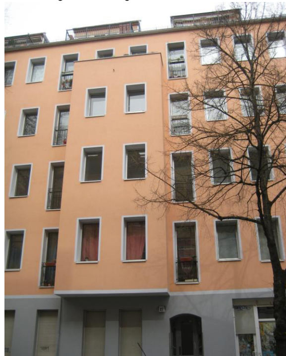
Abbildung 16: Energetisch saniertes Gebäude
