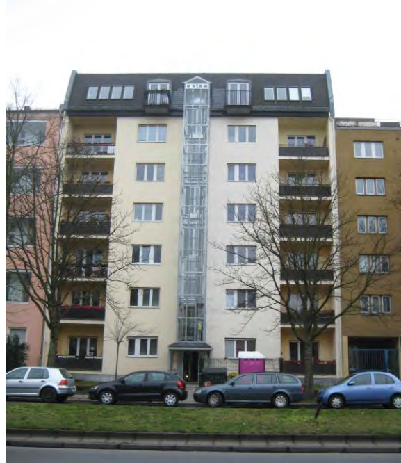
Abbildung 13: Aufzugsanbau und DG-Ausbau
