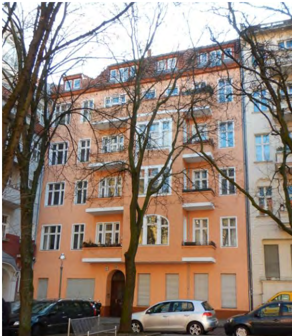
Abbildung 14: Sanierung und DG-Ausbau
