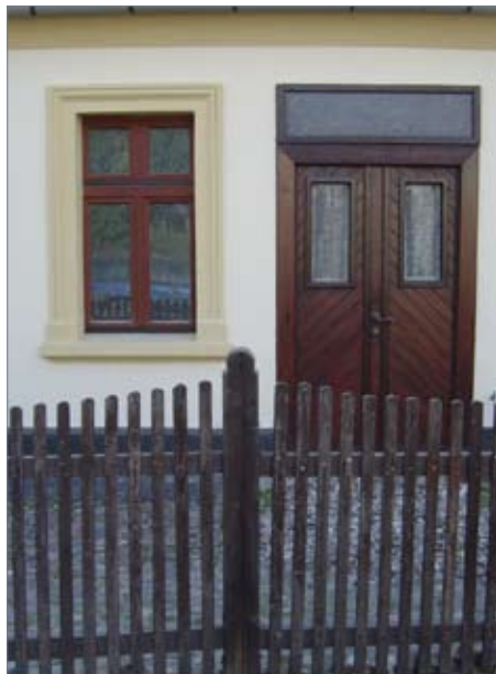
Sehr gute Farbabstimmung von Fenster, Tür und Putzfläche, Prierosser Straße 34
