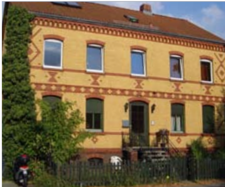
Beispiel für ein prägendes Gebäude im Gebiet: Repräsentatives, gründerzeitliches Mietshaus, Prierosser Straße 53
