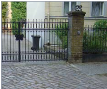
Gut erhalten: gepflasterte Einfahrt und Einfriedung mit schmiedeeisernem Zaun auf Sockel, Prierosser Straße 69
