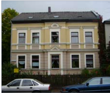
Typische spätklassizistische Fassadenelemente, Alt-Rudow 47a
