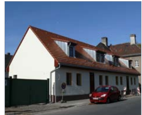
Sehr gute Dachgestaltung mit einzeln stehenden Gauben eines sanierten Gebäudes, Prierosser Straße 50
