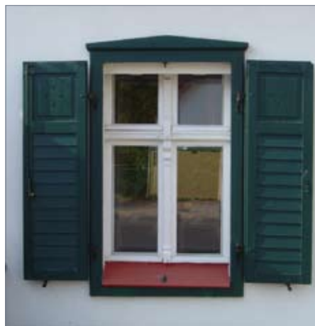
Original erhaltene Fenster mit hölzernen Fensterläden, Krokusstraße 80
