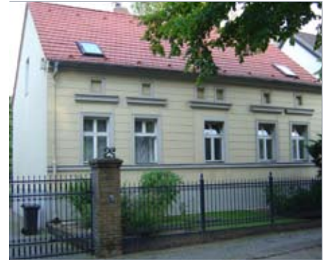
Im Original erhaltene Fassadengestaltung, Prierosser Straße 69
