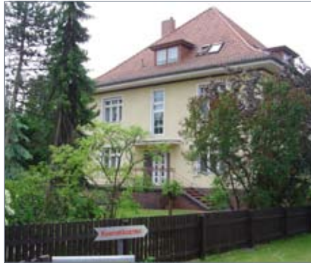
Kleinteilige Bebauung innerhalb privater Freiräume prägt das Ortsbild im Erhaltungsgebiet
