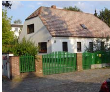
Ruhige, ziegelgedeckte Dachflächen sind typisch im Gebiet, Prierosser Straße 75
