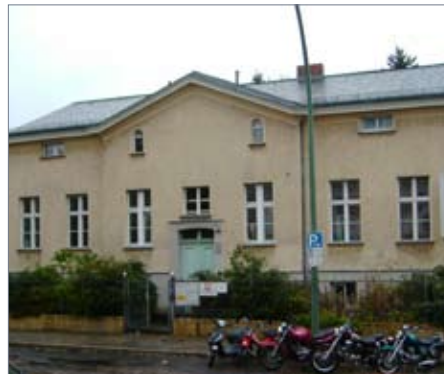
Flach geneigtes Satteldach mit Schieferdeckung, Alt-Rudow 42-44
