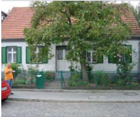
Beispiel für ein prägendes Gebäude im Gebiet: Kleines bäuerliches Wohnhaus, erbaut um 1820, Alt-Rudow 32
