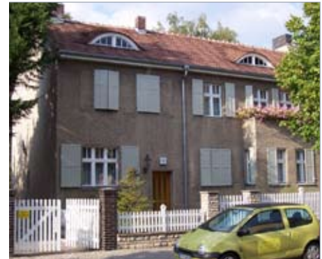
Schlichte Fassadengestaltung eines Miethauses, um 1930, Krokusstraße 92
