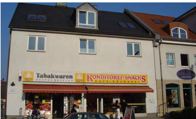
2-geschossiges Wohn- und Geschäftshaus, um 1980 errichtet, Alt-Rudow 41
