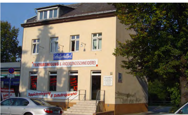
Gründerzeitliches kleines Mietshaus mit Gewerbeanteil, Alt-Rudow 55
