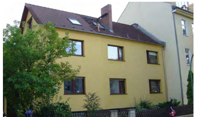
Wohnhaus nach 1950, zweigeschossig, Köpenicker Straße 167
