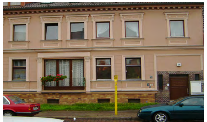
Fehlende Einfriedung macht Vorgartenbereich zum öffentlichen Abstandsgrün, Alt-Rudow 28.
