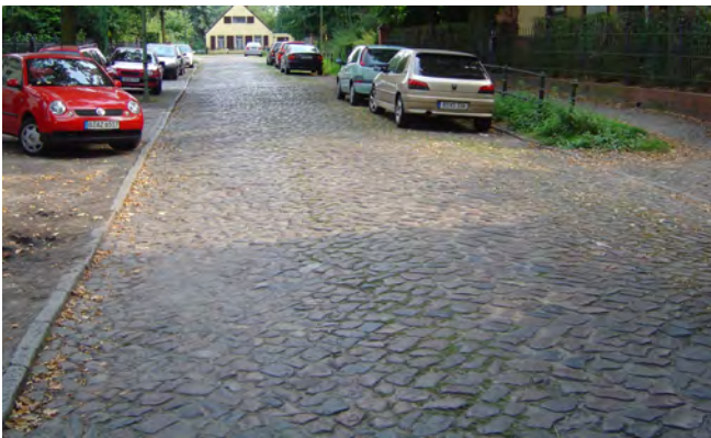
Südlicher Straßenabschnitt Prierosser Straße in Wildpflaster
