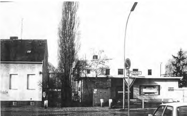
3. 1986: Abriss des Ernhauses und ehem. Mars-Kinos auf dem Grundstück Alt-Rudow 24.
