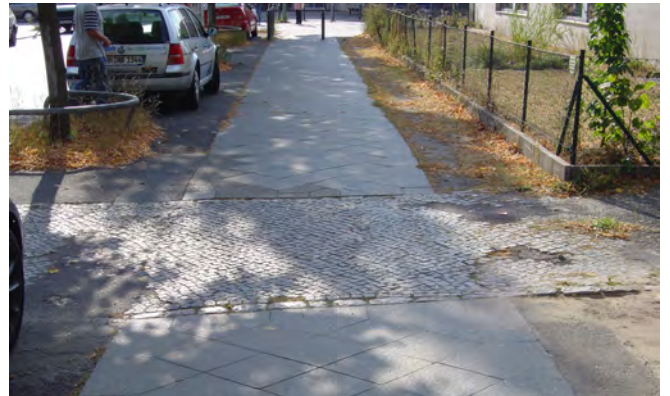
Krokusstraße: breiter Gehweg im nördlichen Bereich mit integrierten Pkw-Parkplätzen
