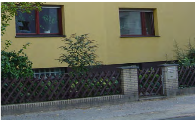
Ortsuntypische Einfassung mit Jägerzaun, Köpenicker Straße 167
