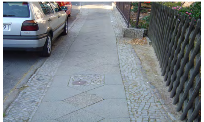
Prierosser Straße: Gehwegbereich im nördlichen Abschnitt in Betonplatten mit Seitenrändern aus Mosaik
