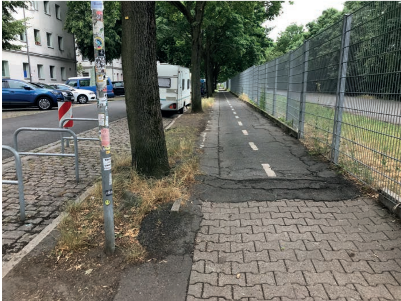
Oderstraße, Asphaltband entlang des Tempelhofer Feldes (24.06.2021)
