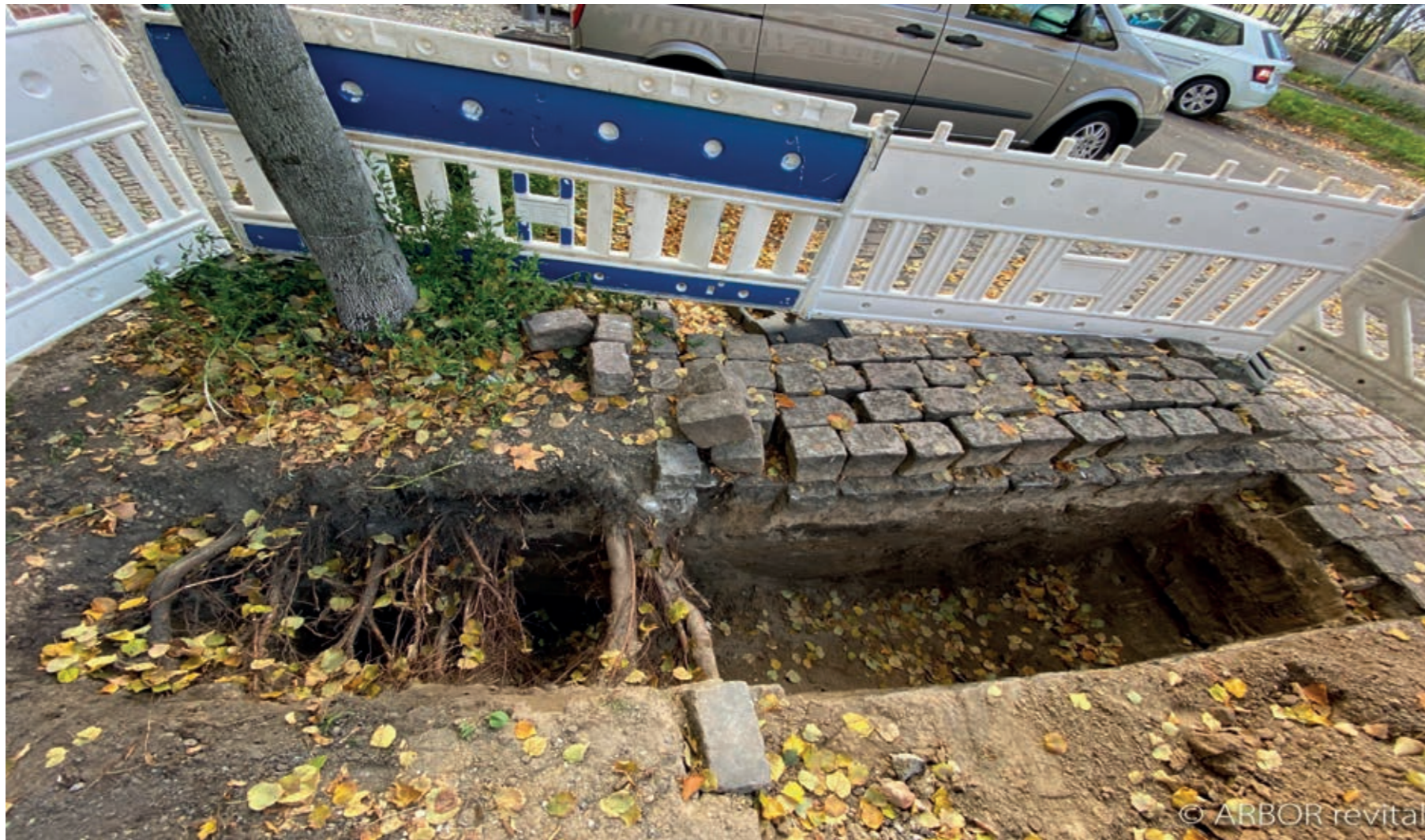
Wurzeln ausschließlich im Bereich der Baumscheibe und des Gehwegs, keinerlei Wurzelwerk unterhalb der Stellplätze
