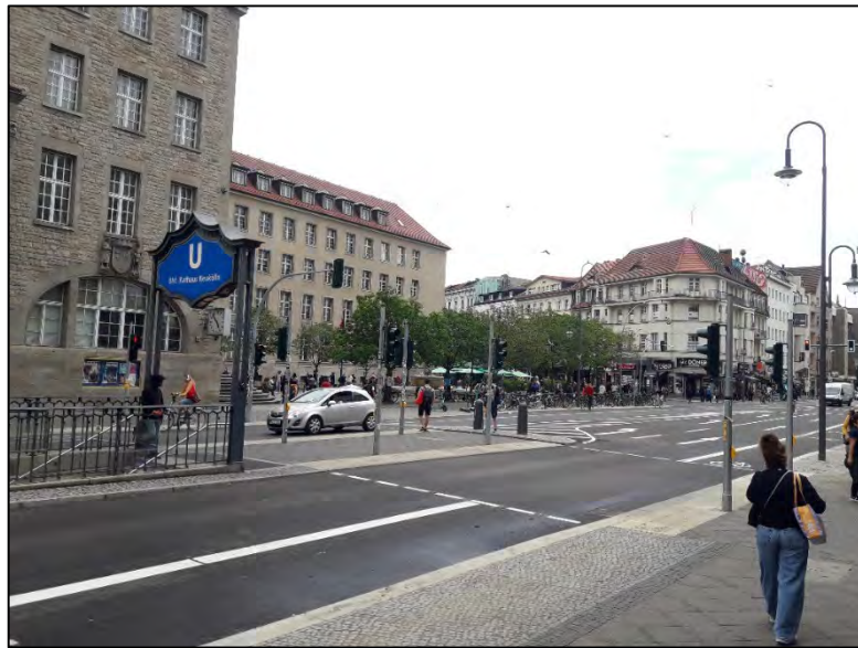
Fertigstellung Karl-Marx-Straße 3. Bauabschnitt
