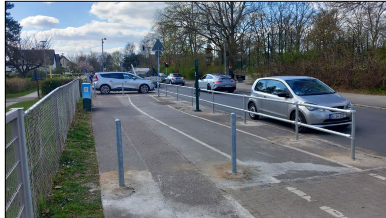
Verkehrsschutzgitter Schliemann-Schule (Groß-Ziethener Straße)
