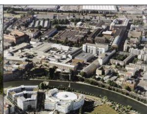
Gewerbegebiet Moabit - Meilenwerk
