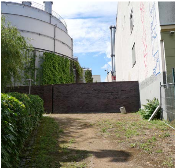
Übergangsbereich R 19 - HKW Mitte (Quelle: eigene Aufnahme)
