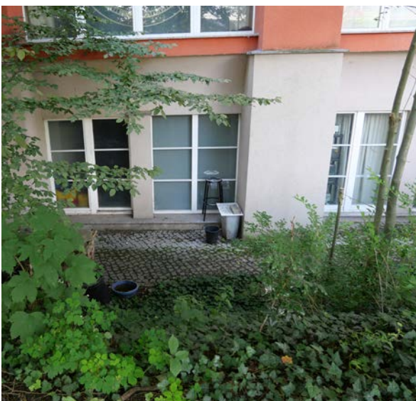
Souterrain Rungestraße 20 (Quelle: eigene Aufnahme)
