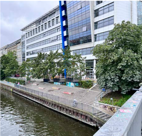
Treppenanlage Jannowitzcenter (Quelle: eigene Aufnahme)
