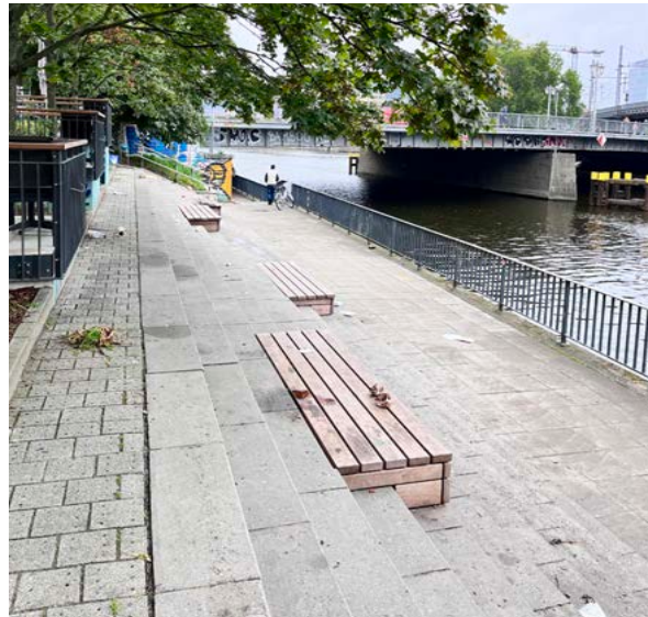
Treppenanlage Jannowitzcenter (Quelle: eigene Aufnahme)
