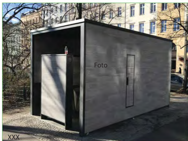
Öffentliches Toilettenhäuschen am Weinbergpark
