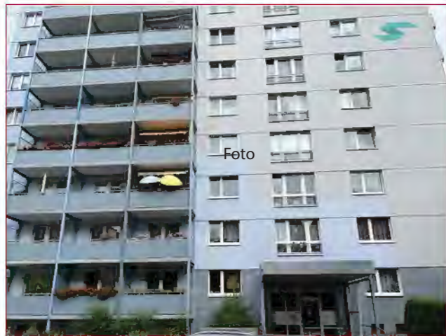
Individuell sanierter QP 59 in der Neuen Blumenstraße
