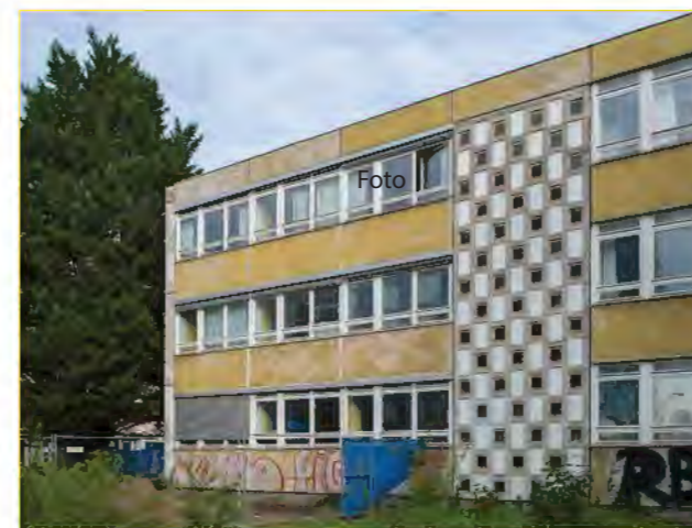
Charlotte-Pfeffer-Schule, Bauteil E
