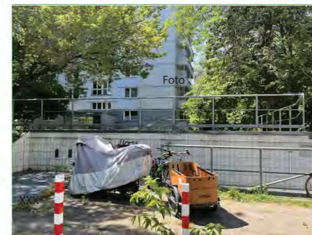
Vattenfall-Anlage, Neue Blumenstraße
