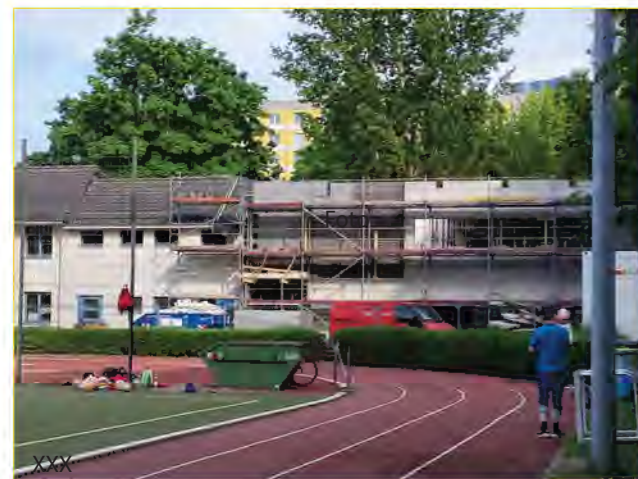
Laufende Bauarbeiten, Stand 2022
