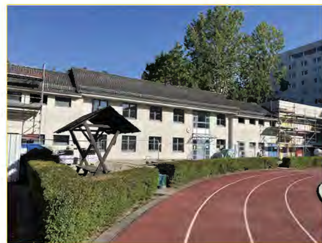
Laufende Bauarbeiten, Stand 2022
