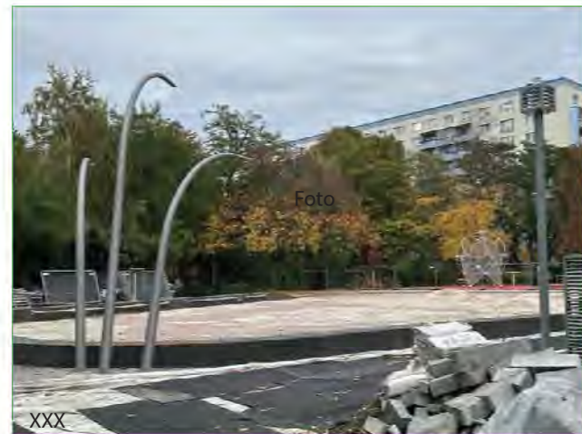
Laufende Umbaumaßnahmen, Stand 2023
