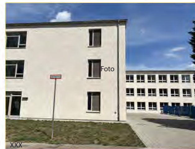
Charlotte-Pfeffer-Schule nach Fertigstellung 1. BA
