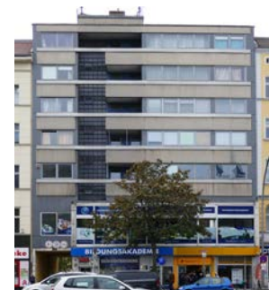
Abb.: Müllerstraße Nr. 156B
