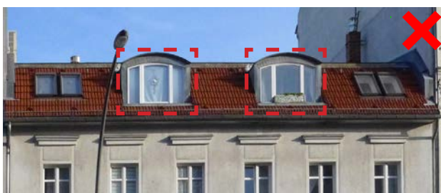
Abb.: Gauben in falscher Form und Proportionierung
