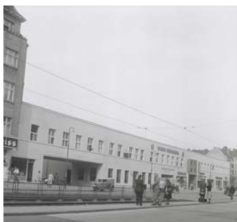
Abb.: Müllerstraße Nr. 123-125 vor Abriss 2012, inzw. Neubau als Lebensmitteleinzelhandel
