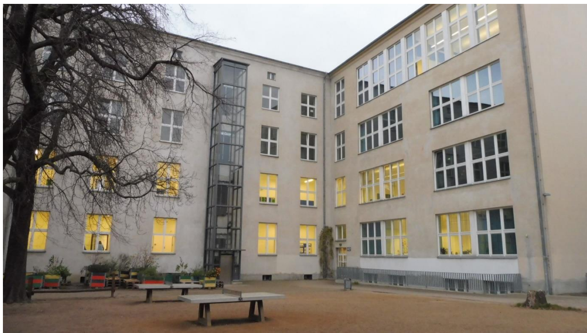
Abbildung 37: Schulgebäude 027-01 - Ansicht vom Schulhof
