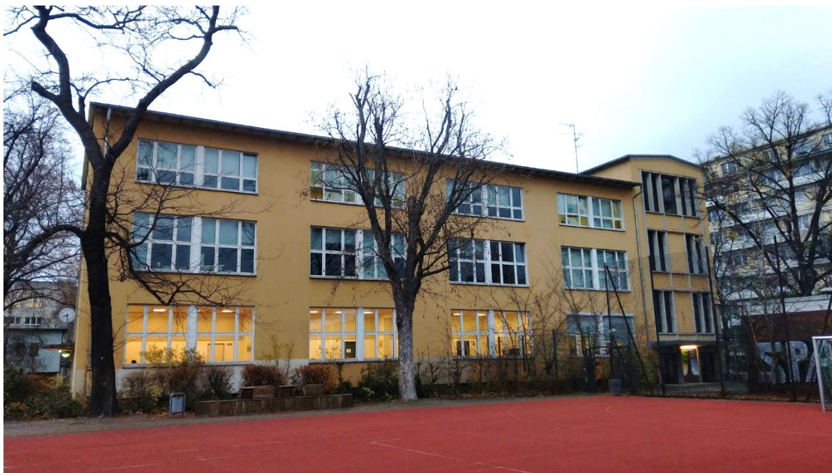
Abbildung 39: Schulgebäude 028-01 - Ansicht vom Sportplatz
