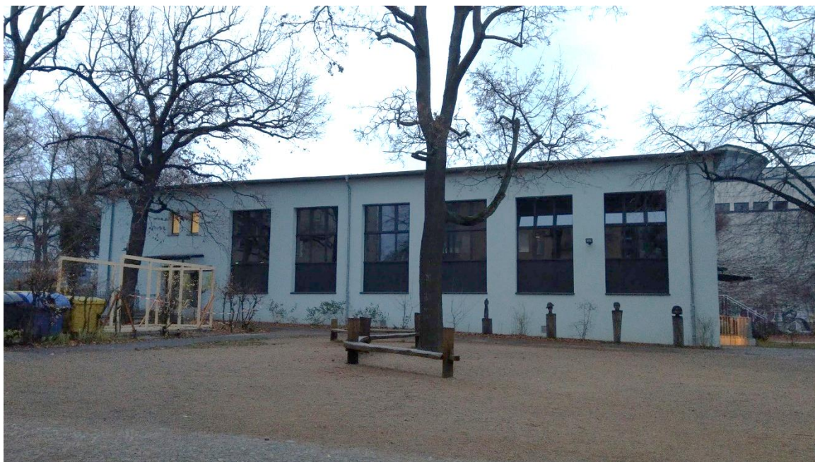
Abbildung 41: Sporthalle 027-02 - Ansicht vom Schulhof
