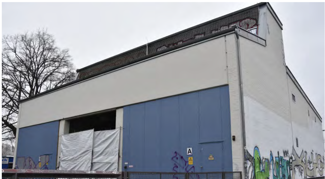
Abbildung 40: Umspannwerk Stromnetz Berlin, Böttgerstraße 29 (2023)
