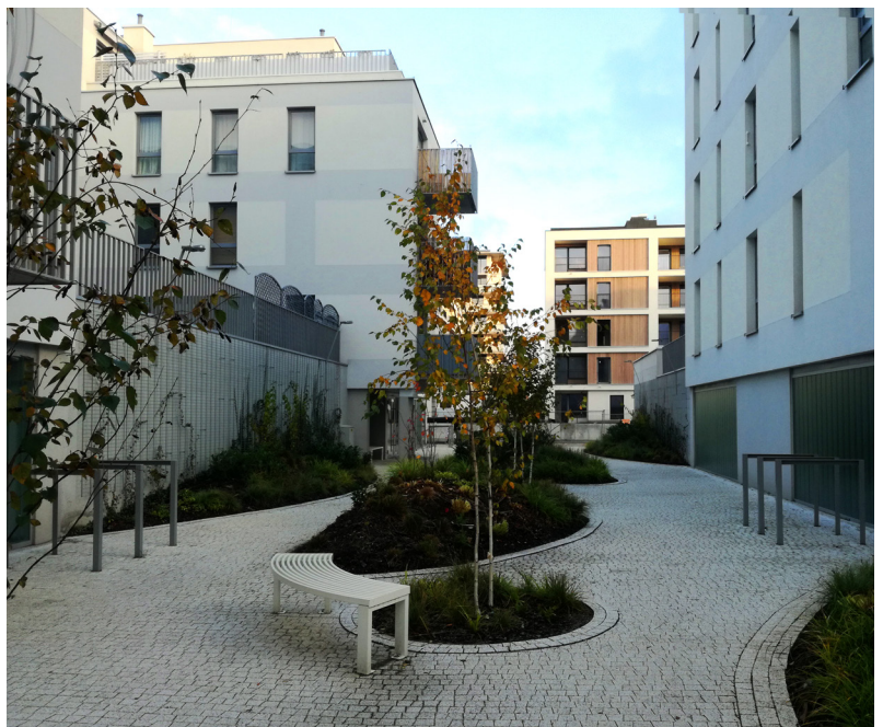
der fertige erste Bauabschnitt in Nowe Żerniki
