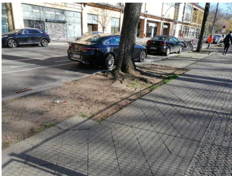
Abbildung 16: Erweiterte Baumscheibe in der Ungarnstraße. Das Regenwasser des Gehwegs fließt dank des Gefälles in die Baumscheibe.
