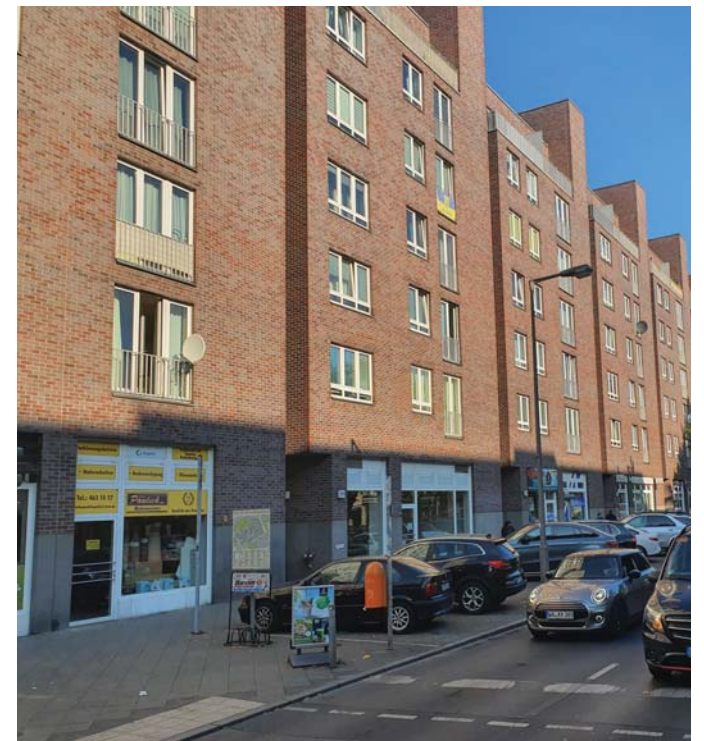
Angrenzende Wohnbebauung an der Brunnenstraße, Foto: BSM mbH
