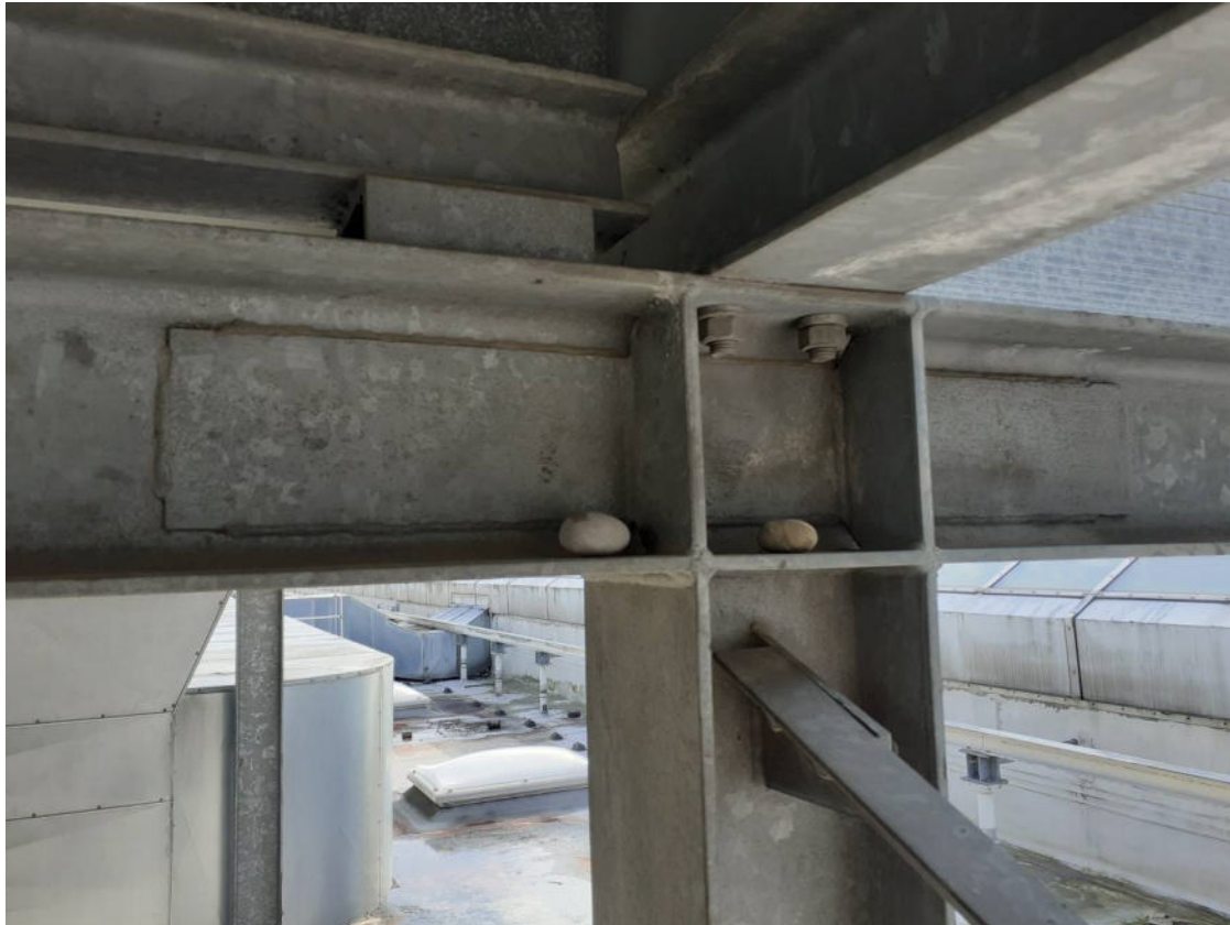
Abb. 4: Nistplatz Potenzial auf dem Dach des ehemaligen „Nixdorf-Gebäudes“.
