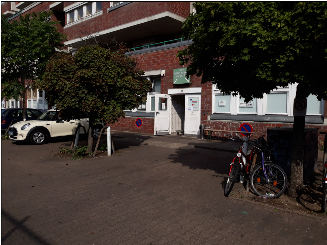
Abb. 4.5: Ansicht Anlieferbereich Kiezküche
