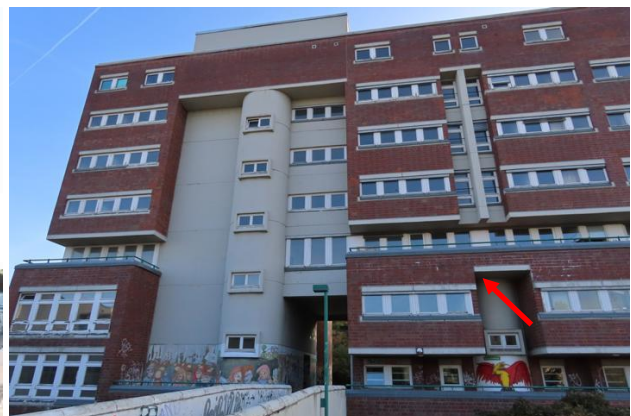
Straßenseite des nördlichen Gebäudeabschnitts (Pfeil - Standort eines Schwalbennestes)
