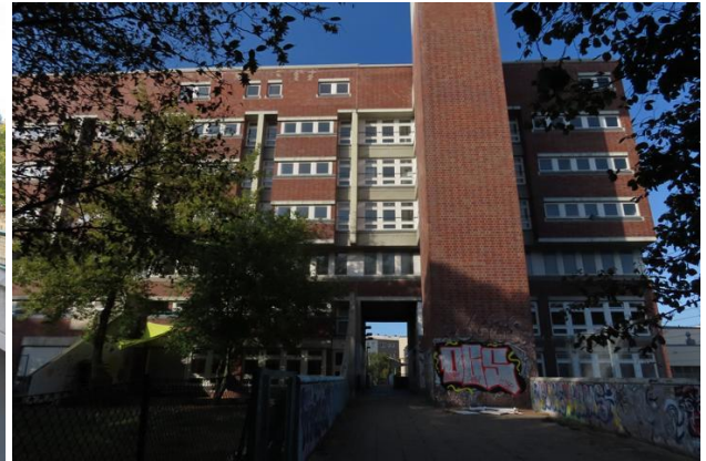
Rückseite des nördlichen Gebäudeabschnitts
