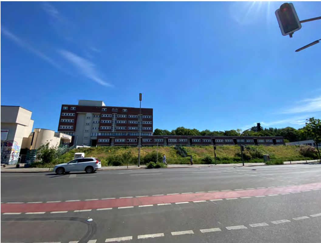
Abb. 2: Von den Maßnahmen betroffene Bestandsgebäude (Blickrichtung Nord-Ost). Links im Bild: Kernsanierung des 7-geschossigen Gebäudes vorgesehen. Rechts im Bild: Abriss des 3-geschossigen Gebäudes vorgesehen.
