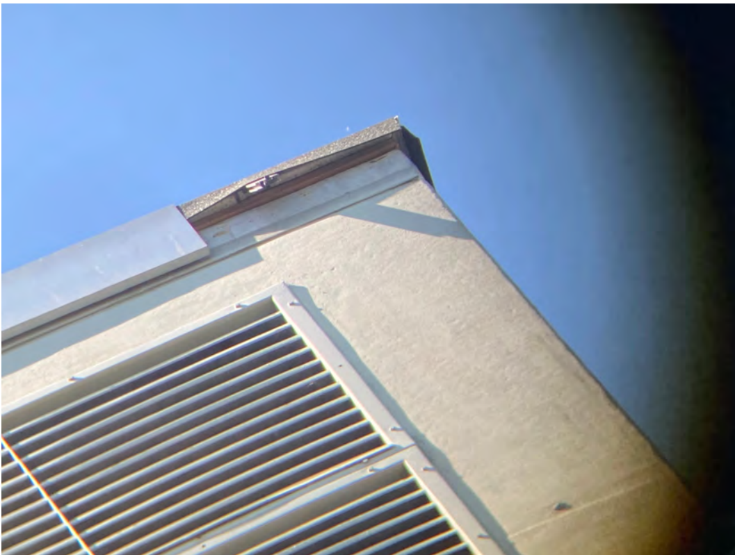
Abb. 3 Detailansicht Attika/Dachaufbau. Fest verschraubtes Holz auf Betonunterlage.
