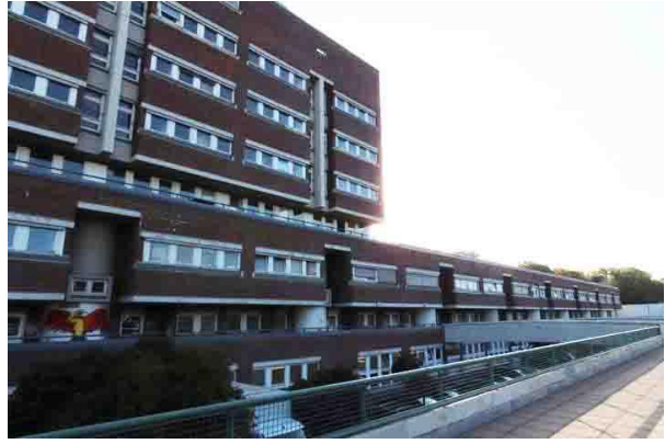
Abb. 5: Südlicher Teil des Gebäudes
