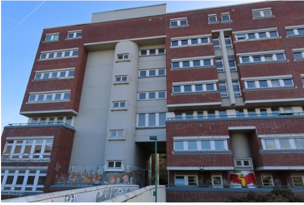
Abb. 4: Nördlicher Teil des Gebäudes
