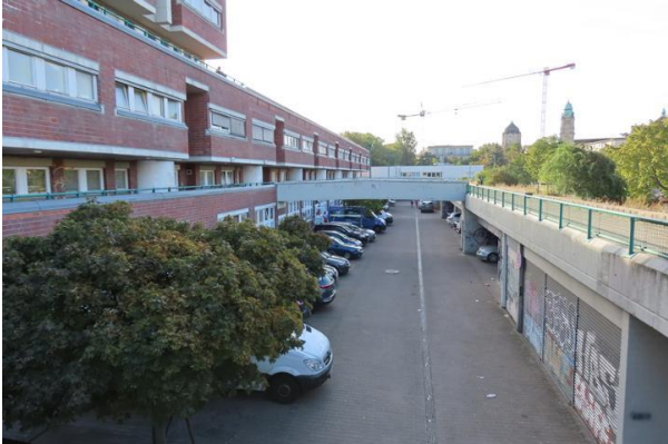
Abb. 6: Zufahrt zwischen dem Gebäude und dem begrünten Wall
