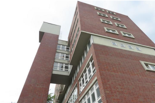
Abb. 8: Nördlicher Giebel des Gebäudes
