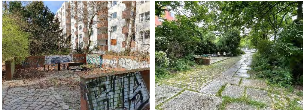
Abb. 65: Gestaltungselement Mauer ohne Stadtmobiliar, illegale Müllentsorgung, Stralsunder Str., Quelle: BSM
