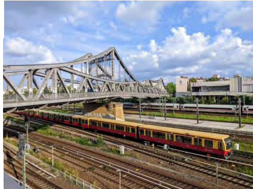
Abb. 54: Swinemünder Brücke, Quelle: BSM
