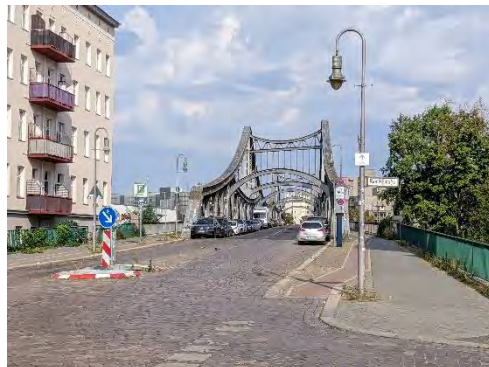
Abb. 89: Swinemünder Straße und Swinemünder Brücke, Quelle: BSM
