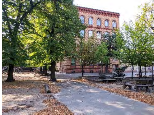
Abb. 35: Vineta-Grundschule, sanierungsbedürftige Außenanlagen, Quelle: BSM
