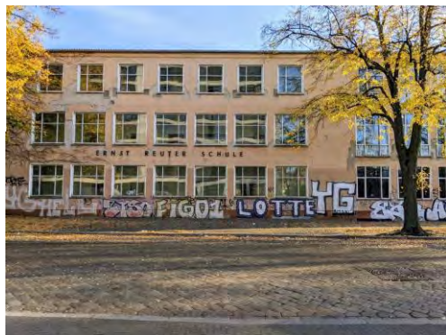
Abb. 39: Sanierungsbedürftige und unter Denkmalschutz stehende Ernst-Reuter-Schule, Quelle: BSM
