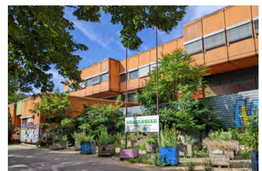
o. Leerstand Brunnenstraße 70/ 71 u. ehem. Diesterweg-Gymnasium
