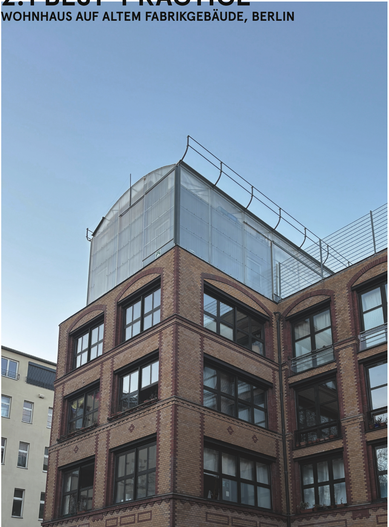
Foto Aufstockung auf Fabrikgebäude an der Uferstraße; Berlin-Mitte (bjp 2025)
