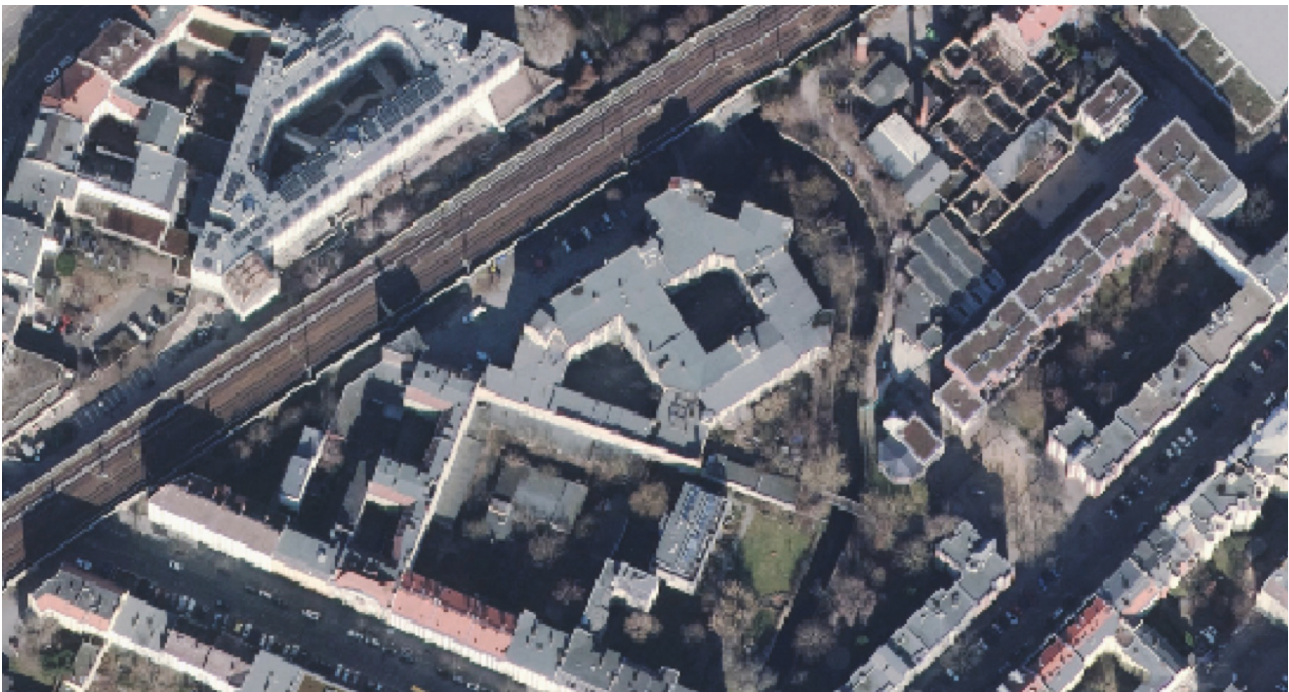
Luftbild Industriegebäude an der Gerichtsstraße; Berlin-Mitte (Digitale Orthophotos 2025-Geoportal Berlin, berlin.de)
