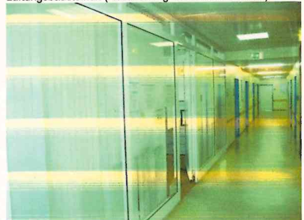
Nicht klassifizierte Feststellverglasungen Raum 4.01 zum notwendigen Flur
