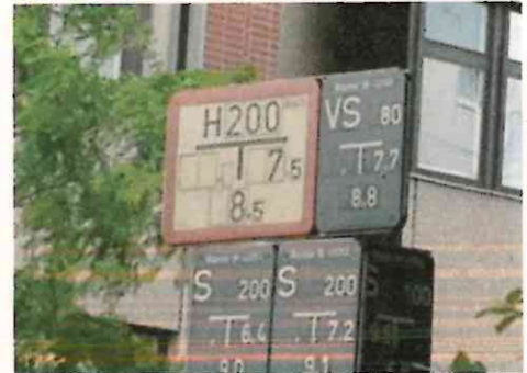
2 x Unterflurhydranten (rot) H 200 an der Etka-Andre'-Straße
