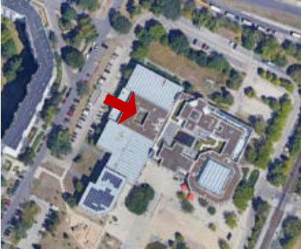
Luftbild Bestand Freizeit Forum Marzahn mit Frauensporthalle und Kegelsportanlage, roter Pfeil zeigt räumliche Lage des Innenhofes
