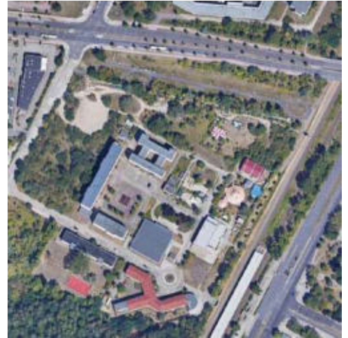
Luftbild Bestand Standort "Bitterfelder Straße" © Google/GoogleGeoBasis-DE/BKG
