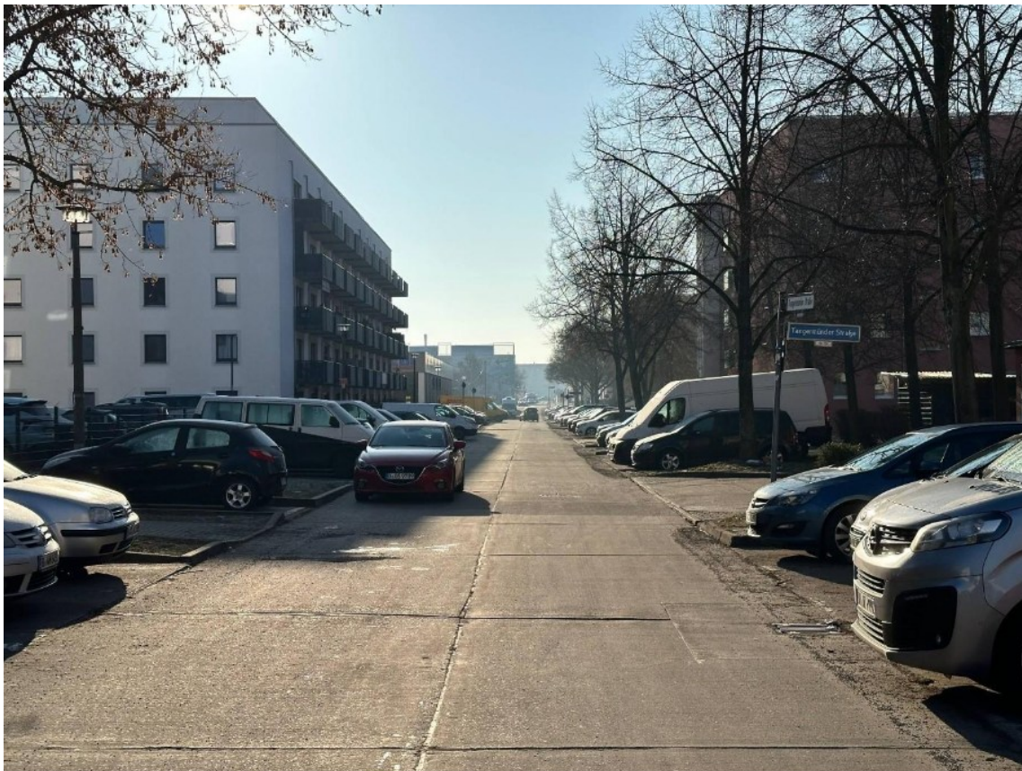
Abbildung 28: Überschwemmungsbereich Tangermünder Str. Foto: GreenAdapt 2026.
