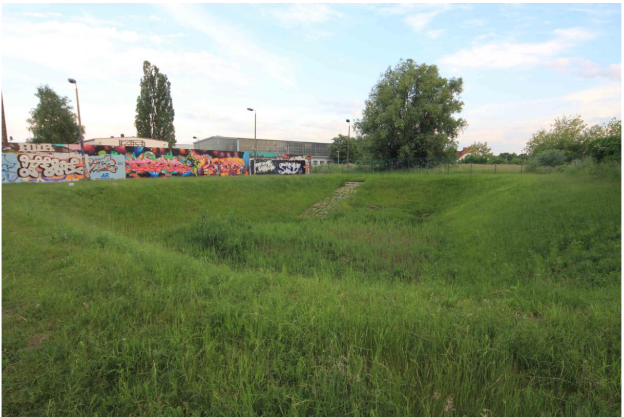
Abb. 9: Im Süden angrenzendes Regenrückhaltebecken, im Hintergrund grenzt das Gewerbegebiet an
