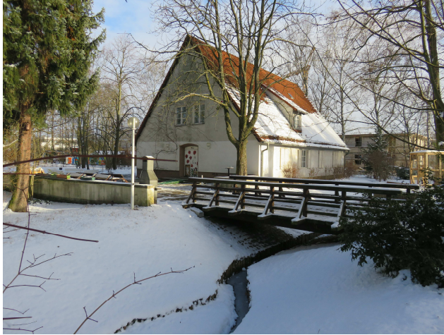
Abbildung 1: Kunsthaus Flora mit Brücke über Wernergraben als Zugang von der Sudermannstraße 1
