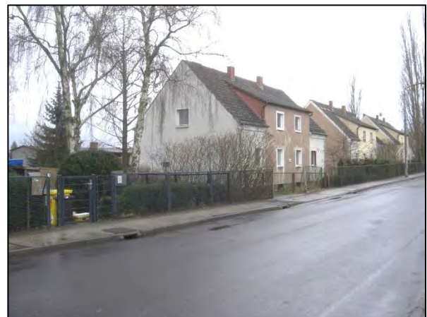
Abbildung 14: Wohngebäude Alte Hellers- dorfer Straße 48, 46 und 44 (Blickrichtung Südosten)
