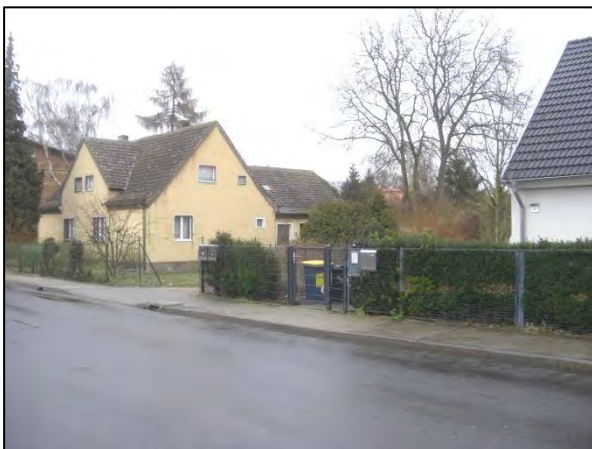
Abbildung 13: Wohngebäude Alte Hellers- dorfer Straße 50/52 und 54/56 (Blickrichtung Nordosten)
