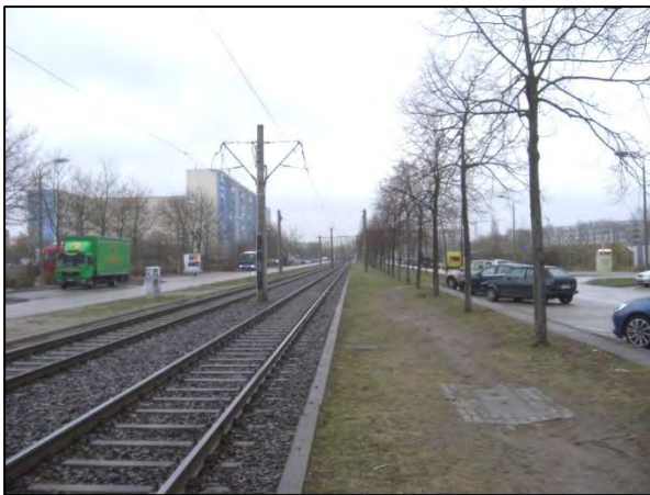
Abbildung 4: Zossener Straße mit Straßenbahntrasse (Blickrichtung Osten)
