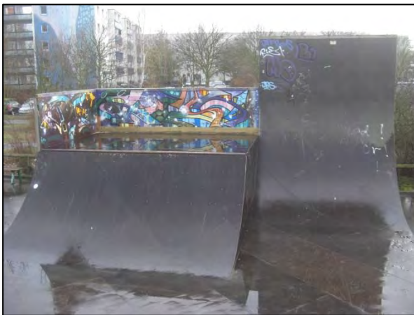
Abbildung 33: Ansicht des südlichen Endes der Minipipes 3 (rechts im Bild) und 4 (links im Bild)
