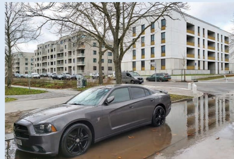
Kastanienallee mi Erneuerungsbedarf
