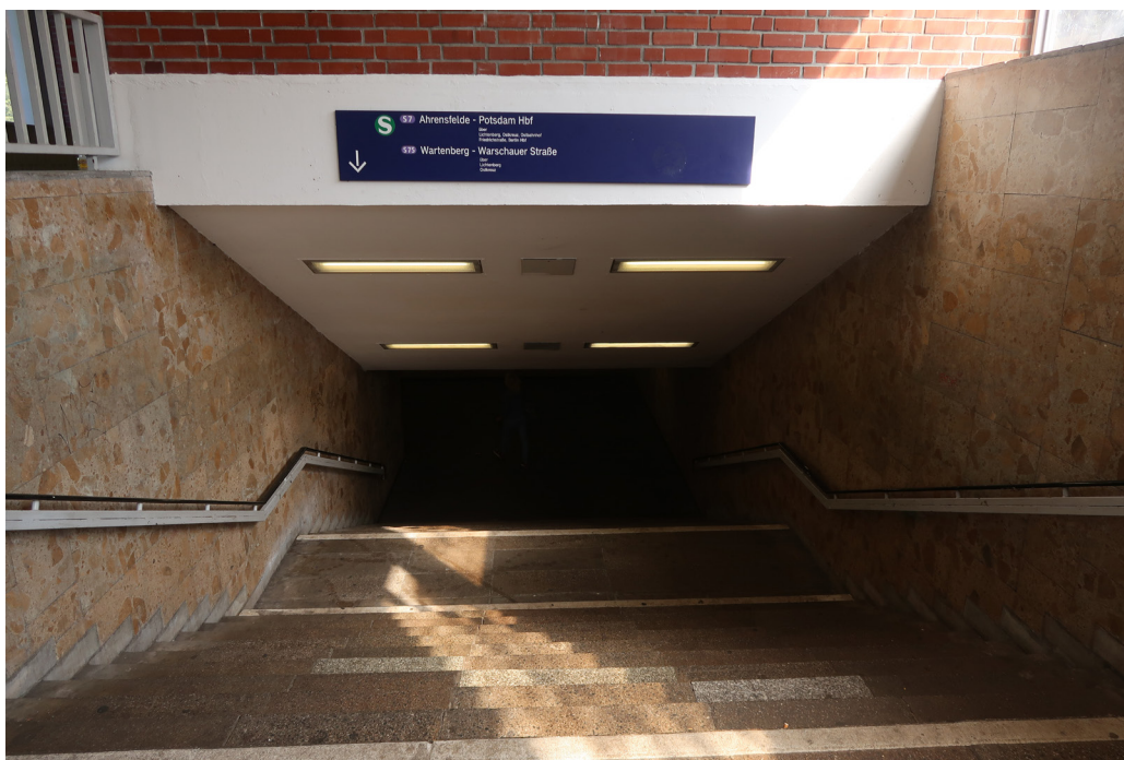
Abbildung 2: S-Bahn Unterführung Springpfuhl
