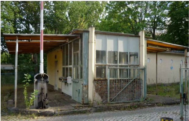
Abb. 15: Pfortnerhaus im aktuellen Zustand
