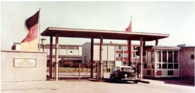
Abb. 10: Durchfahrt und Pforterloge
