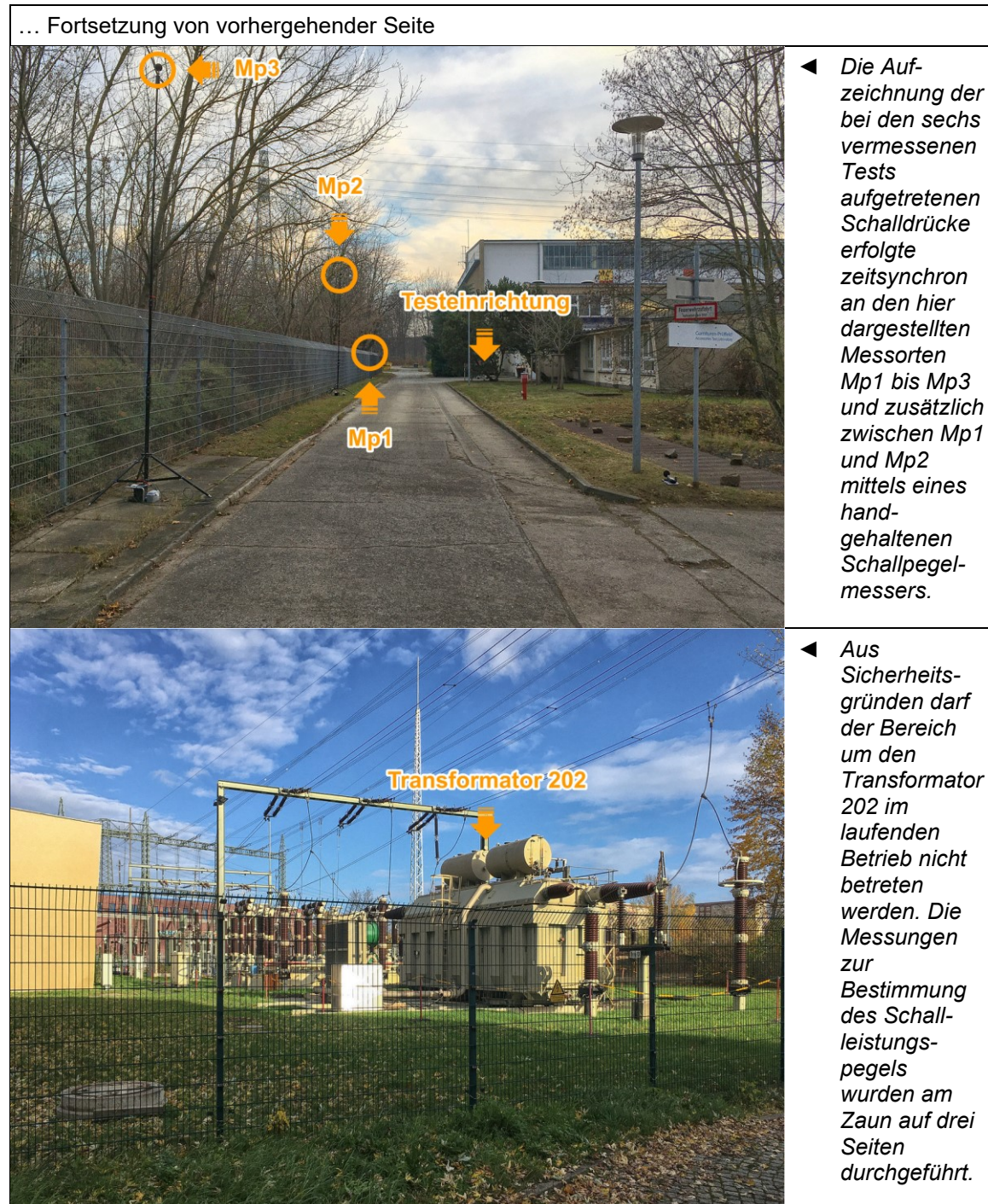
Abbildung 3: Schallemissionsmessungen bei elektrischen Prüfungen im Freien und am Transformator 202 · Fotos zur Illustration der Messsituation.
