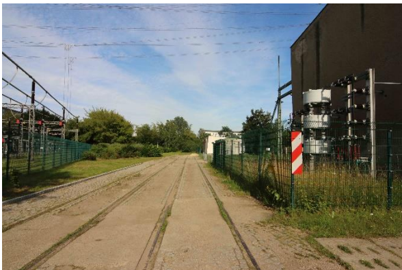
Abb. 23: Zuwegung im Nordosten
