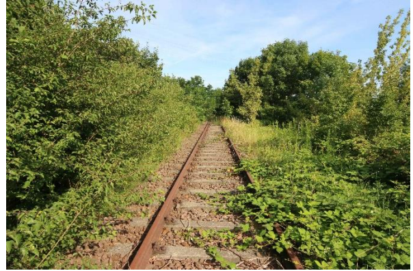
Abb. 10: Offener Bereich des Bahndamms
