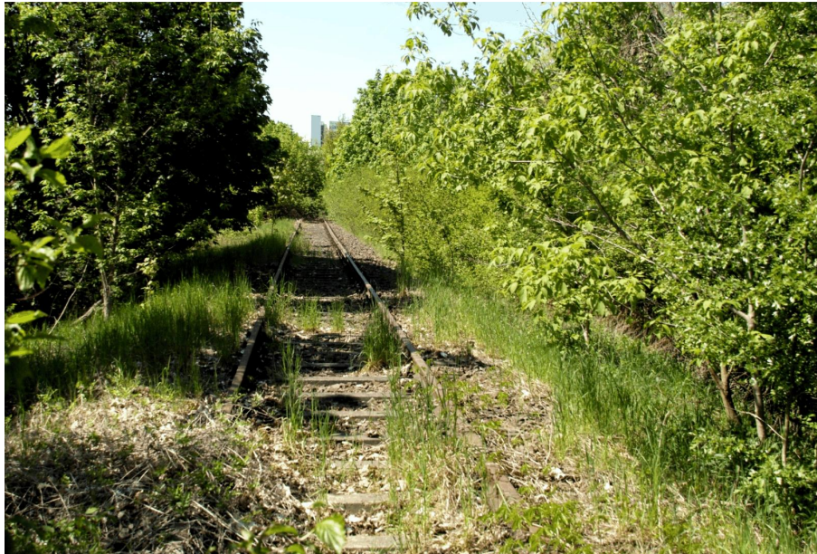
Abb. 41: Bahndamm/Gleisanlagen im Süden des Gebietes
