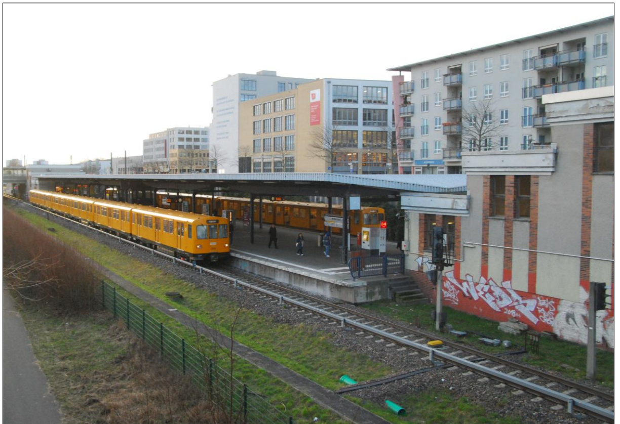
Abb. 14: U-Bhf. Hellersdorf 2023/24 (Foto: Planergemeinschaft)
