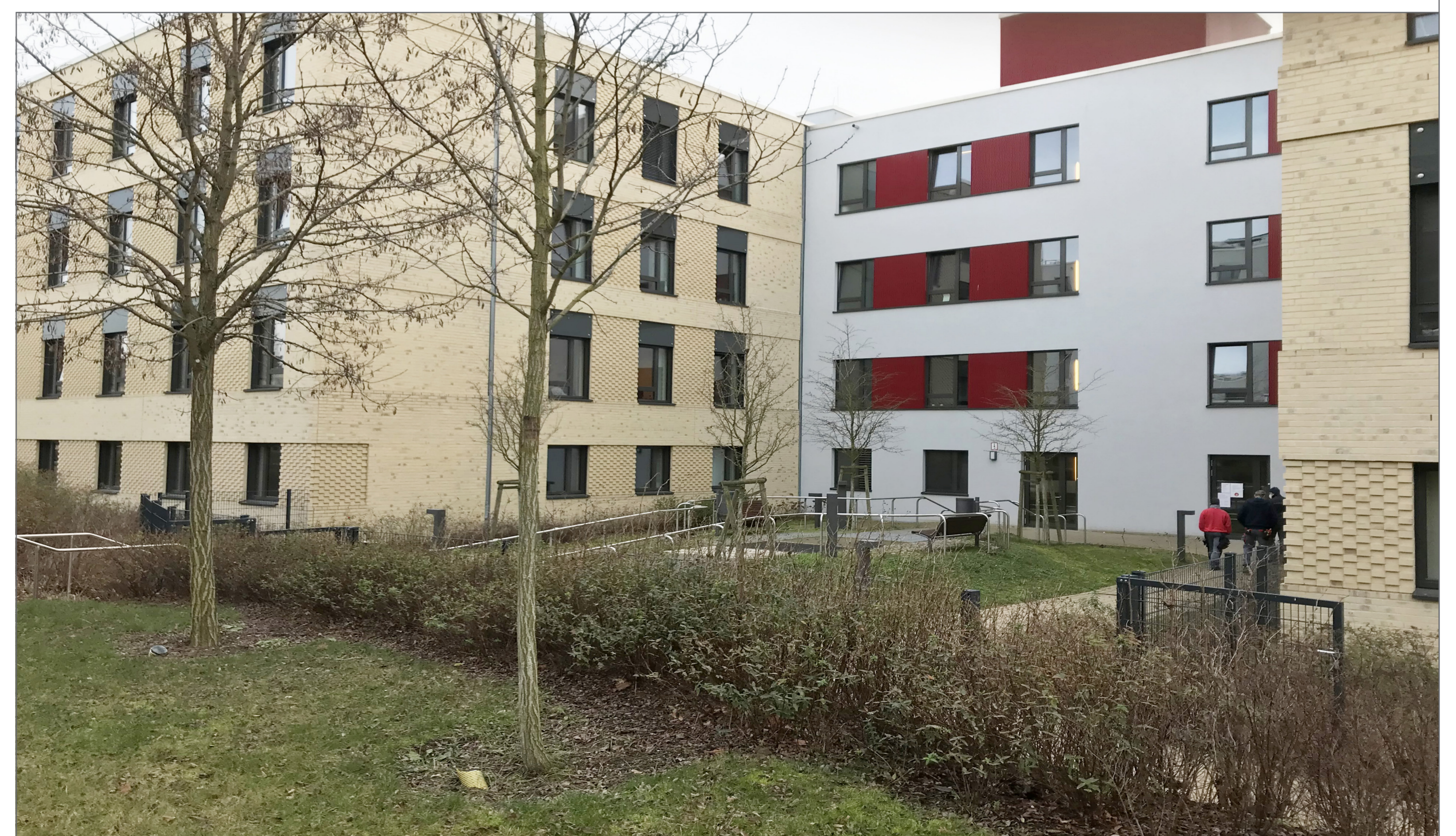
Neubau zur Bestandserweiterung, Nordseite Haus 1 Quelle: BSM mbH
