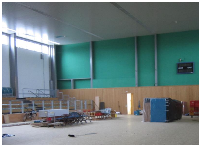
Foto 2: Sporthalle Anton-Saefkow-Platz 5 vor Sanierung
