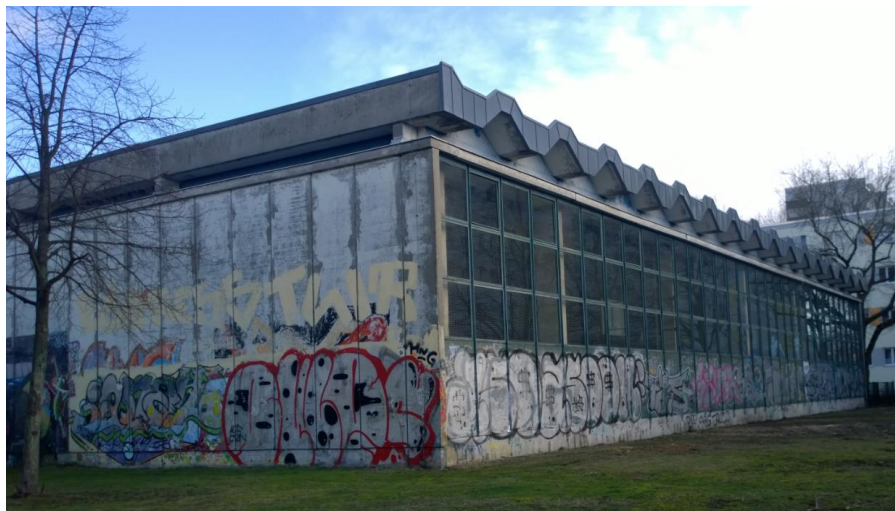
Foto 3: Sporthalle Franz-Mett-Str. 18 vor Sanierung
