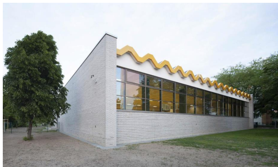
Foto 4: Sporthalle Franz-Mett-Str. 18 nach Sanierung
