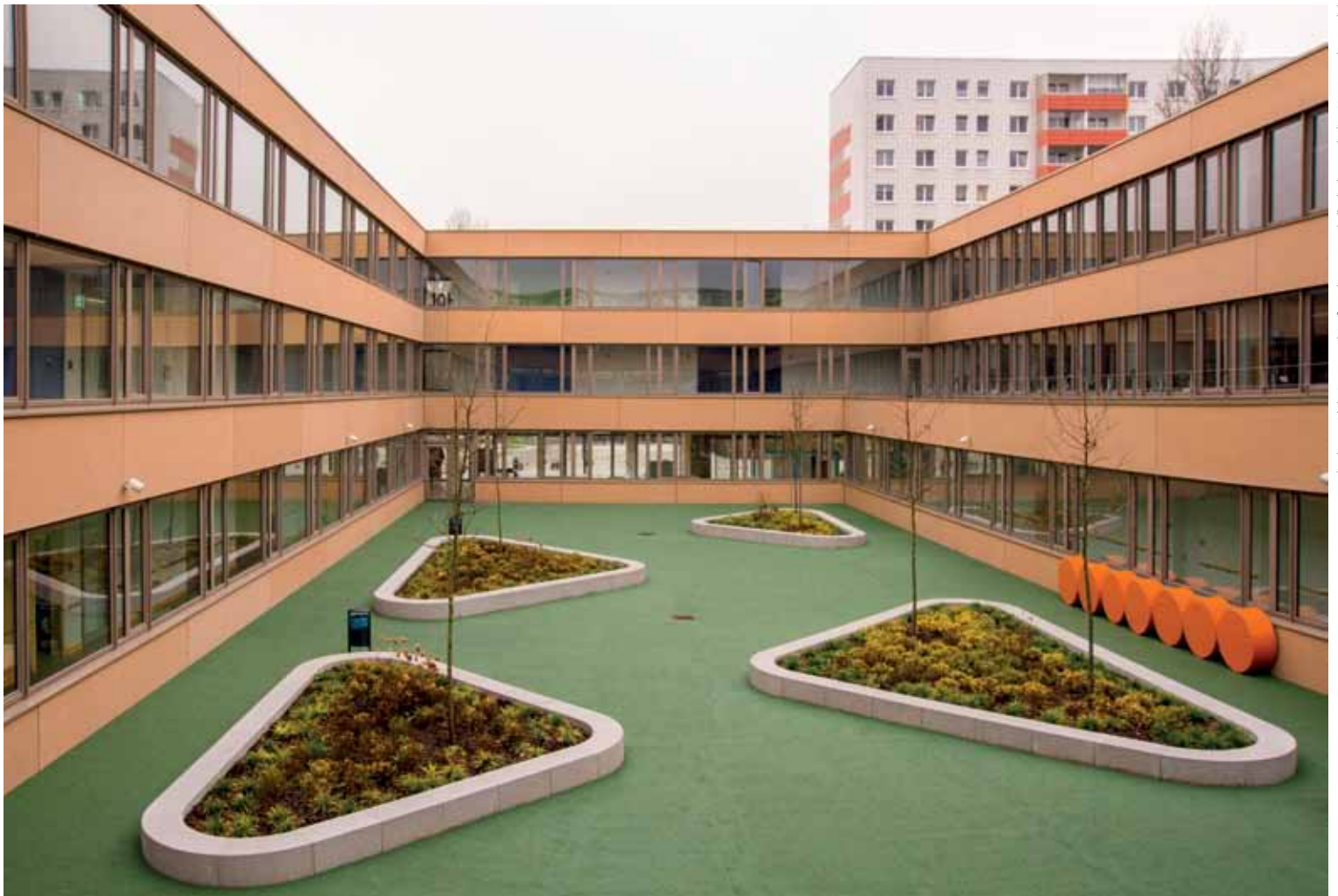
Milstolgerson-Schule, Otto-Marquardt-Strasse, Neubau von Nurnich-Albrecht-Klump-Architekten, 2014, Foto: Idoiger Merschal
