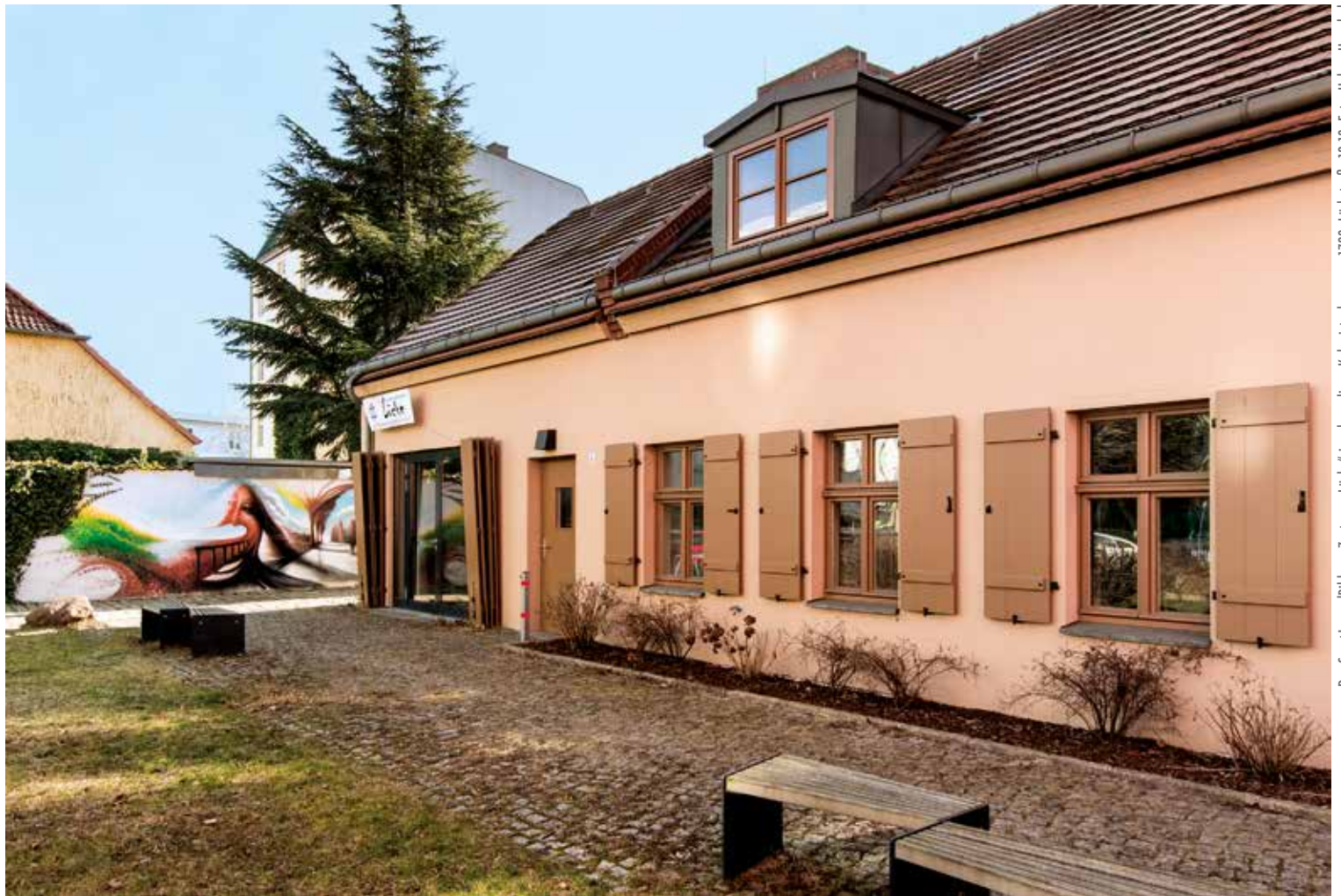
Das SportJugendbildungszentrum „Lücke“ im ehemaligen Kolonistenhaus von 1789, Lückestraße 18-19, Foto: Holger Herschel
