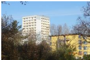
Blick zur Baikalstraße
