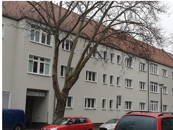
Abbildung 27: Fassade mit WDVS
