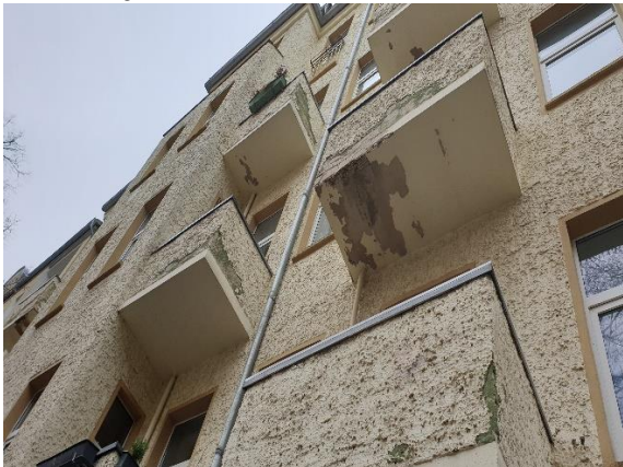
Abbildung 26: Schadhafte Fassade
