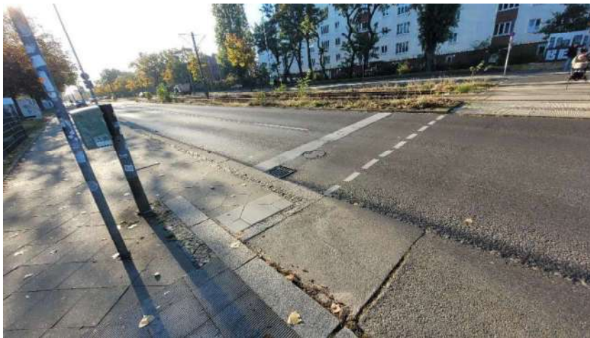
Bild 2.4 Zufahrt südöstliche Hauptstraße
