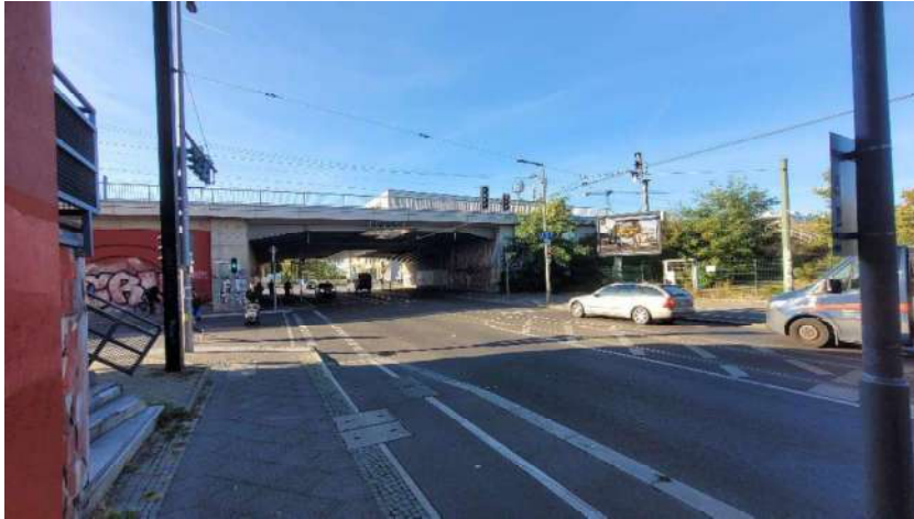
Bild 4.4 Übersicht KP aus Richtung Nordosten
