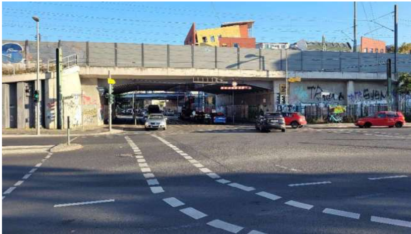
Bild 3.4 Übersicht KP aus Richtung Südwesten
