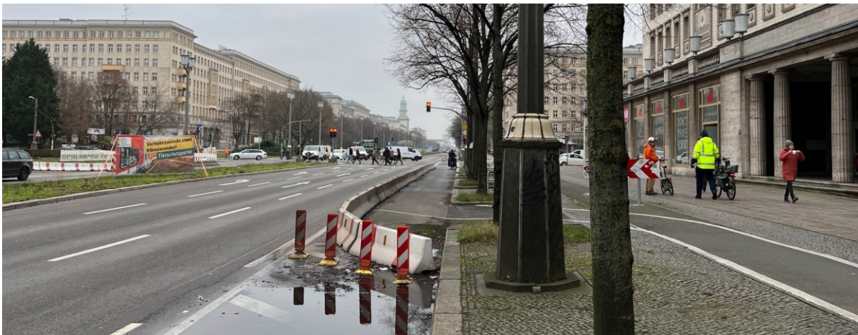
Abb. 5.30 Verschwenkung des weit abgesetzten Radwegs auf die Fahrbahn als von der Unfallkommission Berlin empfohlene Maßnahme zur Minimierung der Häufung von Abbiegeunfällen
