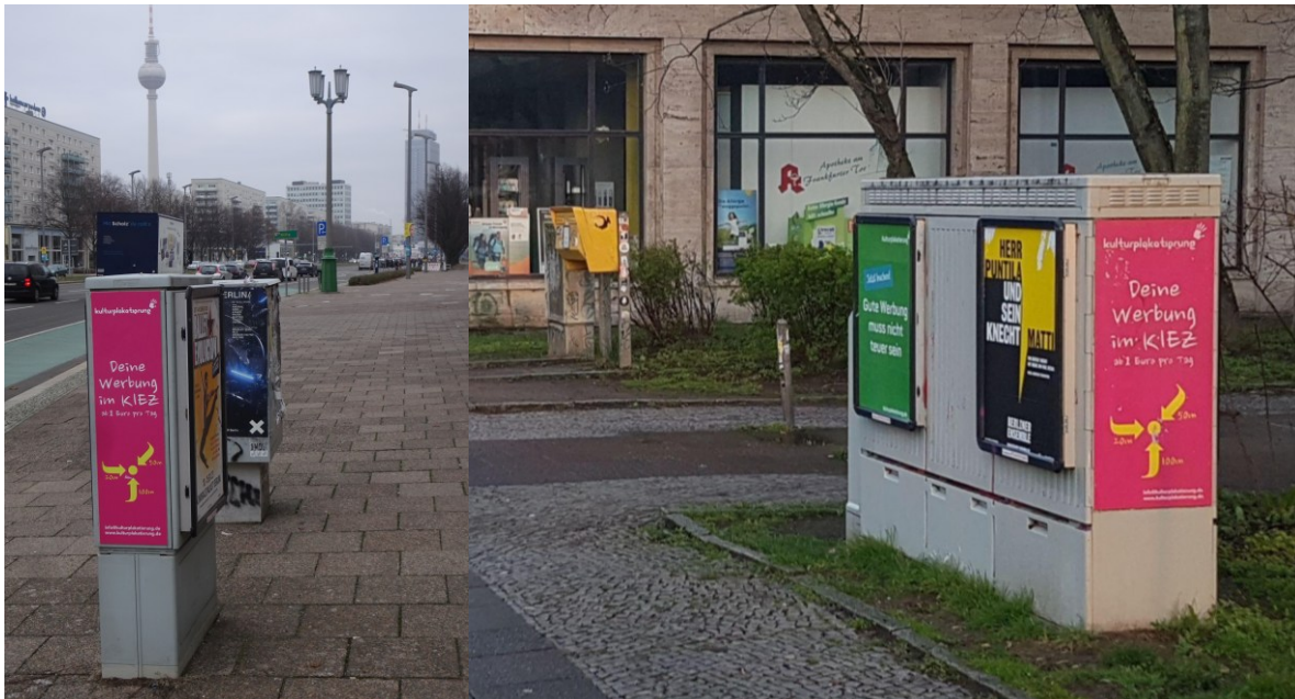
Abb. 5.34 Beeinträchtigung des Denkmalschutzes durch zusätzliche Sondernutzung als Werbeträger Links: Gemeinsamer Standort von Telekom-Verteilerkästen sowie Postverteilerkästen der Deutschen Post; Rechts: zwei Verteilerkästen der Telekom isoliert voneinander
