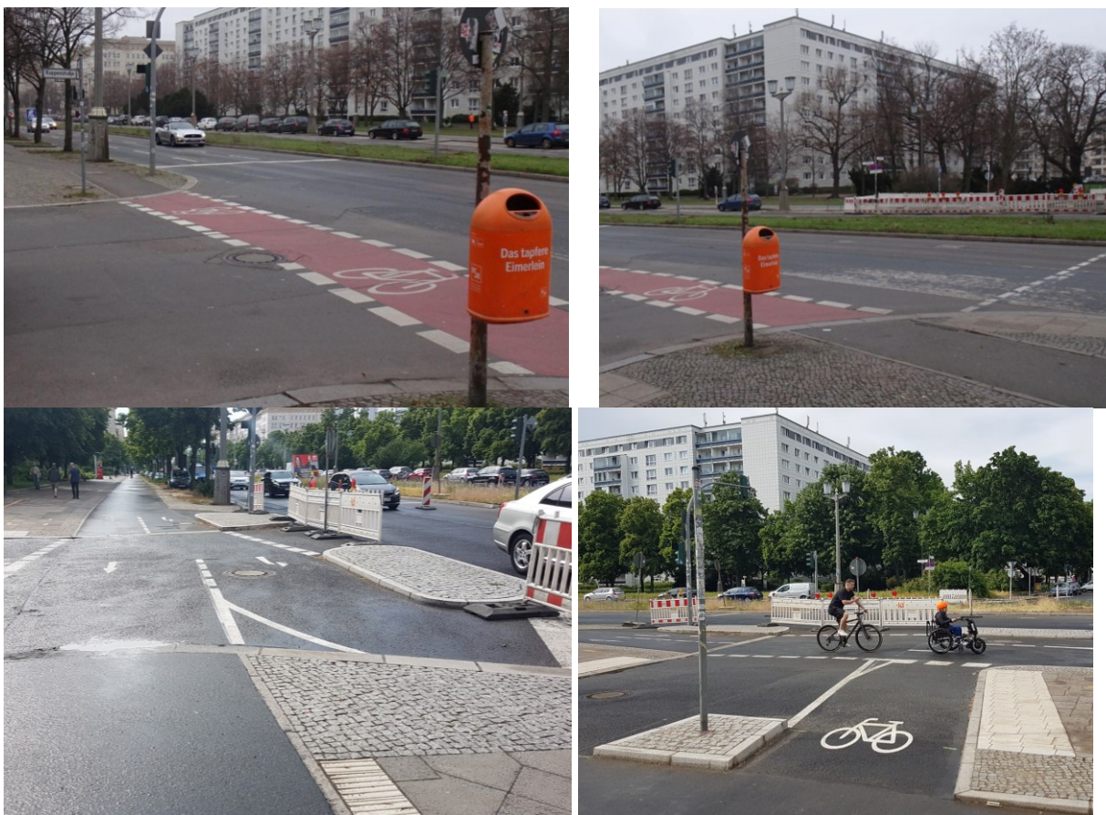
Abb. 5.31 Sicherung der Verkehrsführung klassisch durch Roteinfärbung (oben), oder baulich durch Anpassung der Bordsteinverläufe als optisch zurückhaltende Lösung zur Erhöhung der Verkehrssicherheit und Berücksichtigung des Denkmalschutzes (unten)
