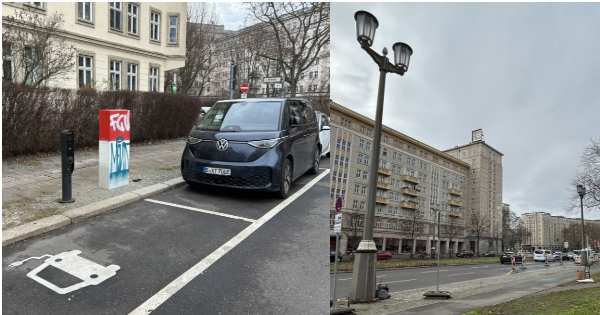
Abb. 5.9 Ladestation mit schmalen und unauffälligen Ladestelen (Anbieter Qwello) sowie separatem zentralem Anschlusskasten (links); Örtlichkeit für die Installation von Ladebordsteinen (Curb Charger, Anbieter Pierburg) als Pilotprojekt (rechts)
