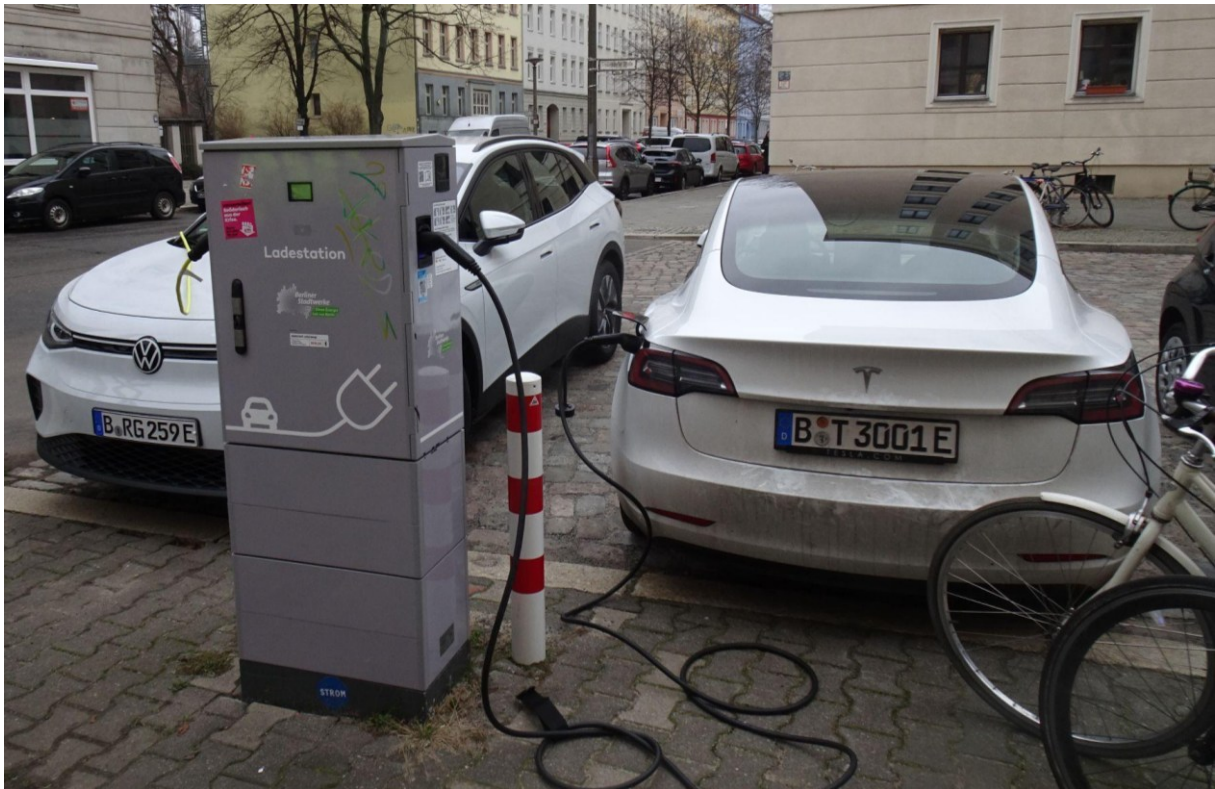
Abb. 5.6 Ladestation im Denkmalbereich (Marchlewski- / Fredersdorfer Straße) mit Rammschutzpfosten
