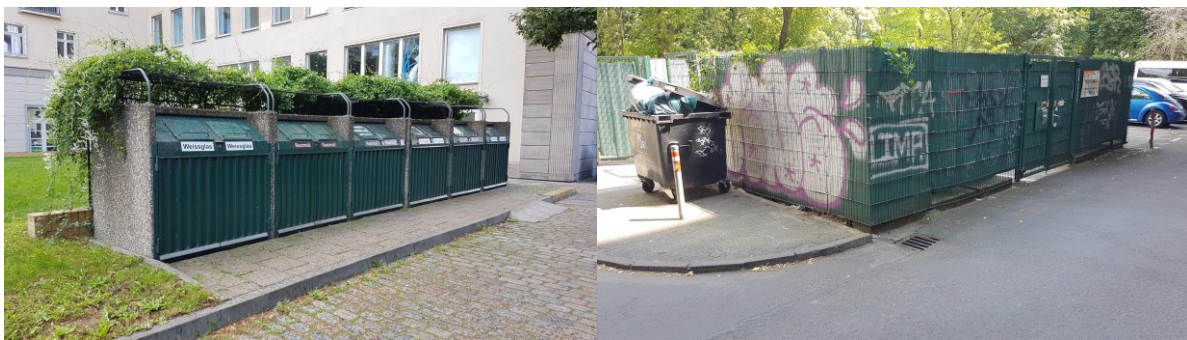
Abb. 5.36 Einhausungen für Müllplätze mit unterschiedlichen Denkmalschutzaspekten
