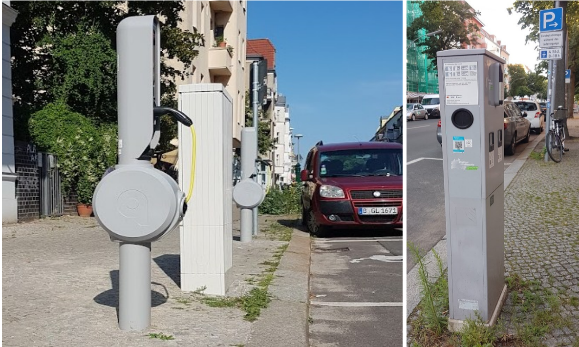
Abb. 5.12 Der Gesamteindruck von schmalere Ladesäulen mit separatem Anschlusskasten (links, Anbieter Qwello) ist teilweise auffälliger als ein Anschlusskasten mit integrierten Ladepunkten (rechts, Anbieter Berliner Stadtwerke)
