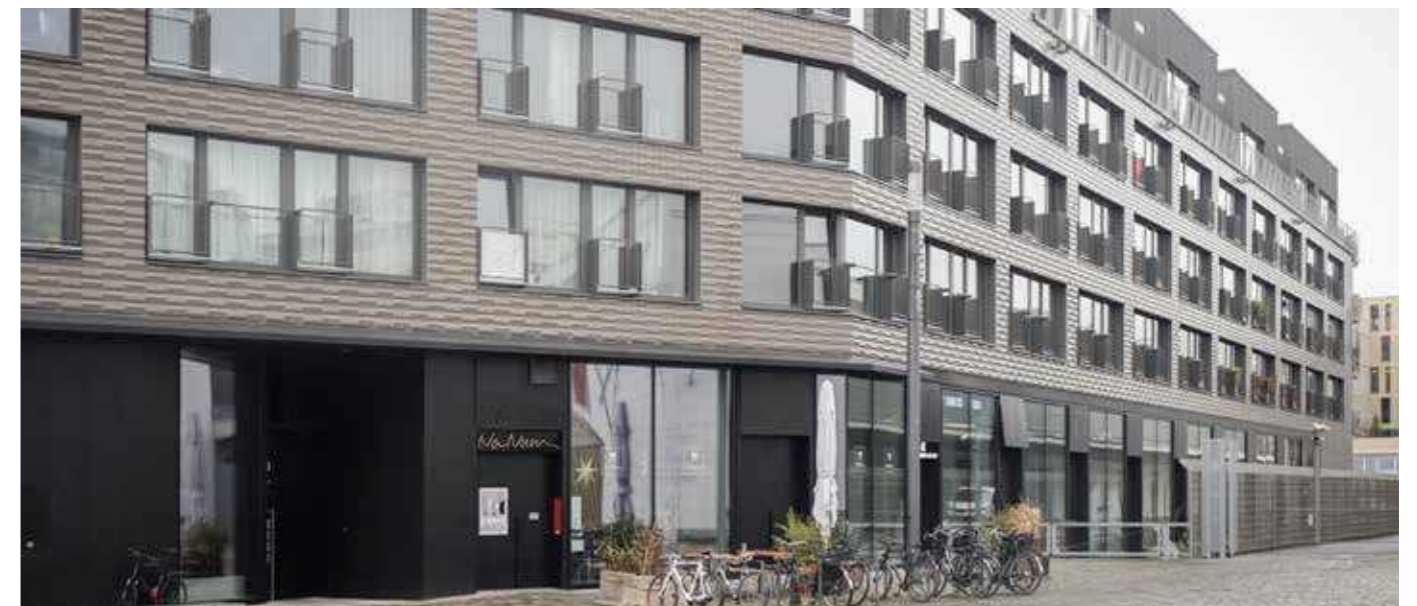
105: Betonung des Erdgeschosses durch Farbgebung und großformatigen Ladenfenstern, In den Obergeschossen eingesetzte vier-gegliederte Fensterelemente, Lindenstraße
