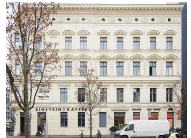
57: Horizontale Gliederung durch Gesimse und Fensterverdachungen über zwei Etagen, Zimmer-/Friedrichstraße
