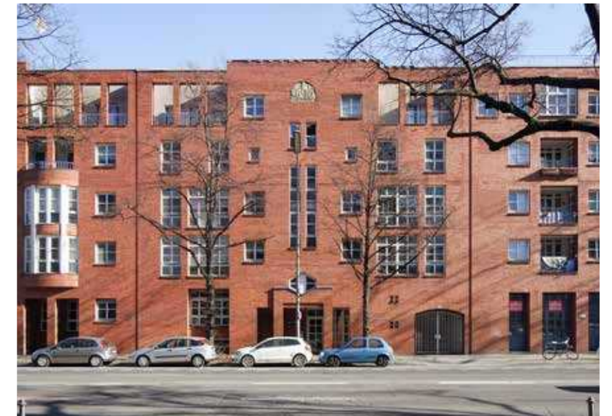
5: Wohngebäude von Rob Krier und Axel Schultes, Lindenstraße
