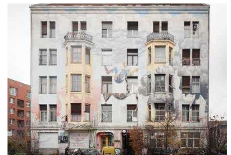
61: Vertikale Gliederung der Fassade durch Erker/Balkone, typischer Schmuck ist entfernt worden, Wilhelmstraße
