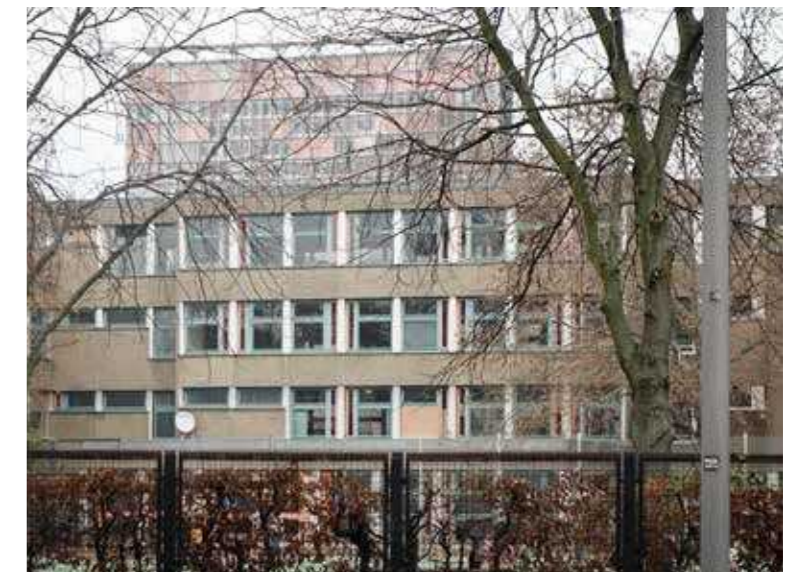
86: Schulbau der Kurt-Schumacher Schule, mit liegend rechteckigen Mehrflügel Fenstern, Wilhelmstraße
