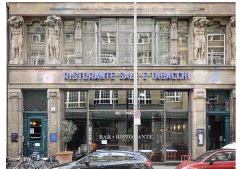
64: Verzierung durch Dekorelemente wie Pilaster und Figuren, Rudi-Dutschke-Straße
