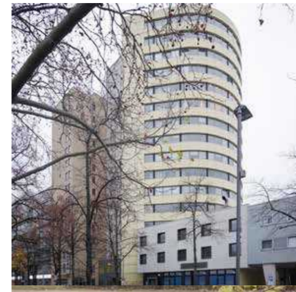
103: Abgerundete Fassade mit Bandfenstern, Stresemannstraße
