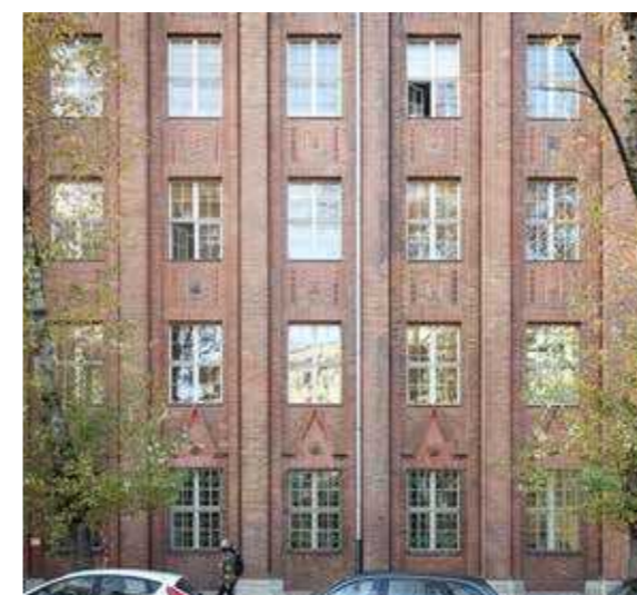
75: Klinkerfassade und axiale Fenstersetzungen, Alte Jakobstraße/ Ecke Oranienstraße
