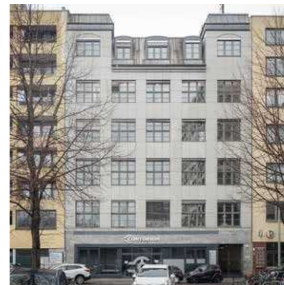
67: Großformatige Fenster und flächige Fassadengestaltung, Friedrichstraße
