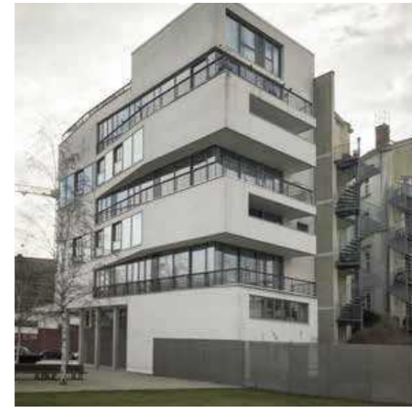
101: Horizontale gegliederte, geschichtete Fassade, Markgrafenstraße
