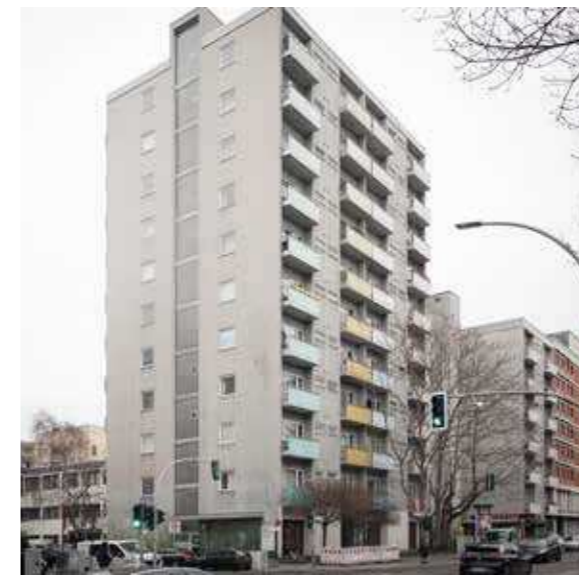
77: Vertikale Verdichtung der Wohnnutzung, Stresemannstraße
