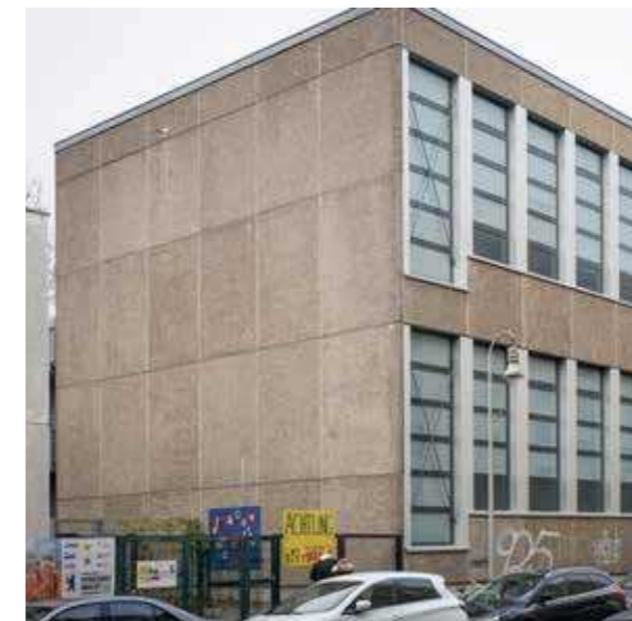
85: Verwendung von Waschbeton, Puttkammerstraße
