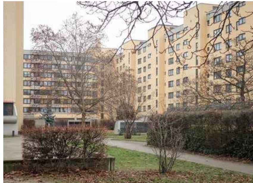
32: Private Freifläche, Innenhof von Wohnbebauung zwischen Puttkamerstraße und Hedemannstraße
