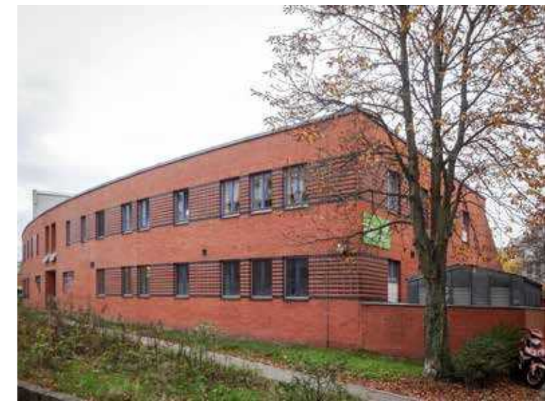
96: Horizontale Gliederung der Fassade durch blaue Fließung mit eingelassenen Zweisprossenfenstern, Fanny-Hensel-Weg
