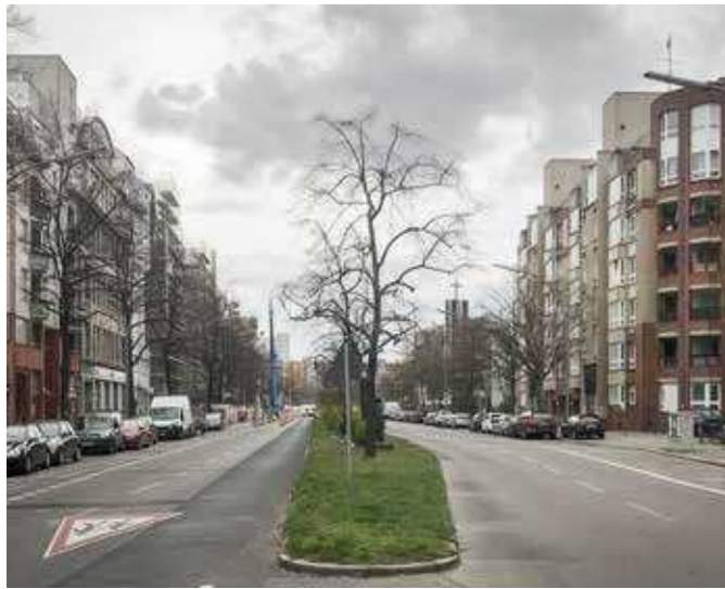
44: Barrierhafte Wirkung durch eingeschränkte Querbarkeit, Wilhelmstraße
