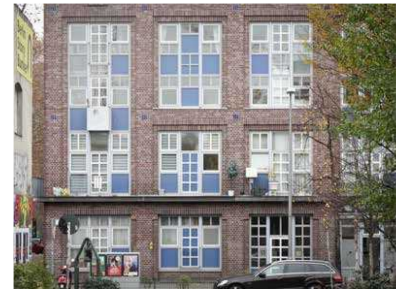
92: Klinkerfassade mit Fenstergruppen mit Mehrsprossenfenstern und Farbapplikation, Am Hafenplatz
