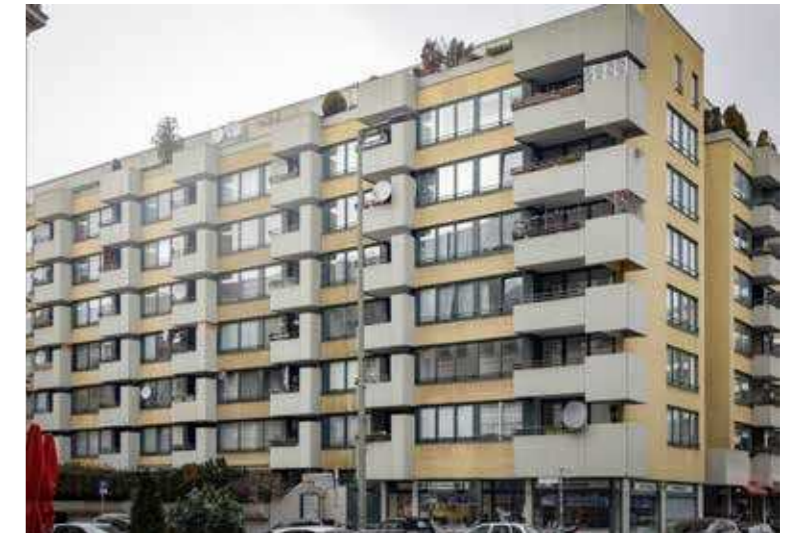
119: Gebäudeensemble, das eine prägende Wirkung im Zusammenhang entfaltet, Wilhelmstraße/ Ecke Hedemannstraße
