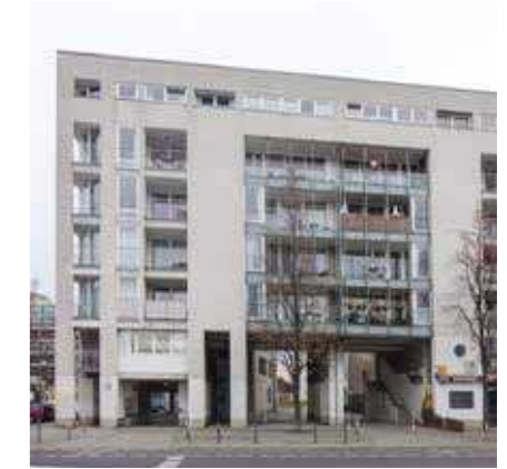
Nr. 27: Wilhelmstraße 42; Zimmerstraße 10
