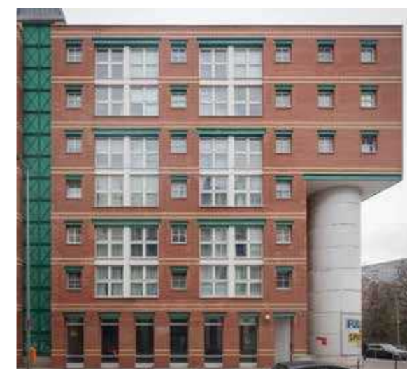
93: Säule als Gestaltungselement, Klinkerfassade mit quadratischen Mehrsprossenfenstern und grünen Farbakzenten, Kochstraße
