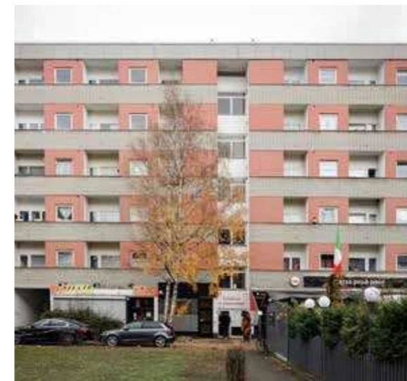
126: Wohnkomplex mit städtebaulicher Bedeutung, Wilhelmstraße
