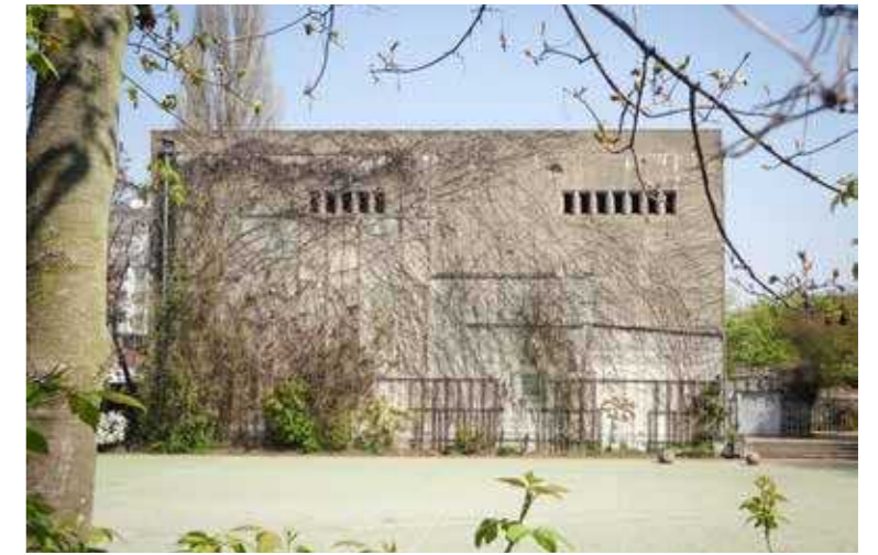
131: Bunker als städtebaulicher Fremdkörper mit kultureller Nutzung, Schöneberger Straße
