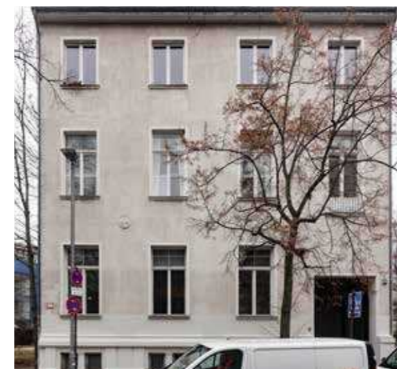
60: Gründerzeitliches Gebäude mit abweichender Traufhöhe und einfach gestalteter Fassade, Wilhelmstraße
