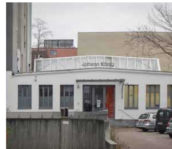
132: Gezielter Bruch mit dem Blockrand und der Traufhöhe in der Umgebung, Galerie Dessauer Straße
