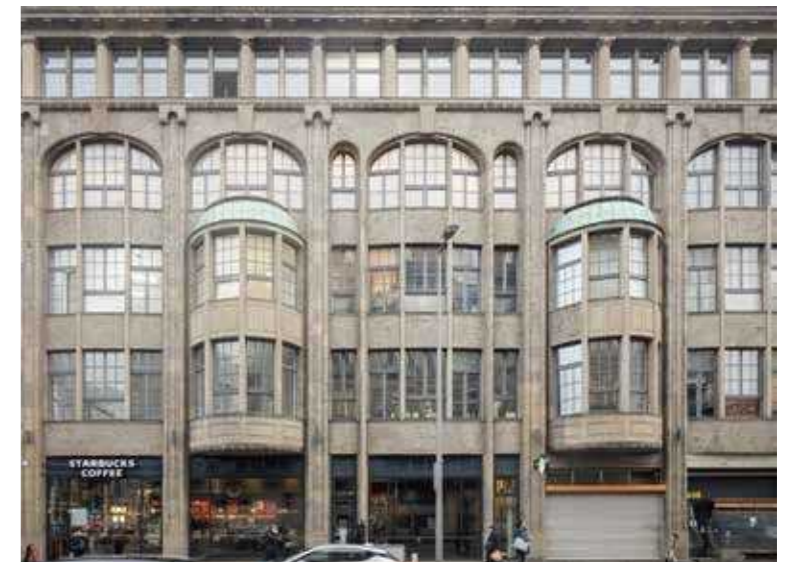
63: Gewölbte Gestaltungselemente, Fensterformen, Kochstraße/ Ecke Friedrichstraße
