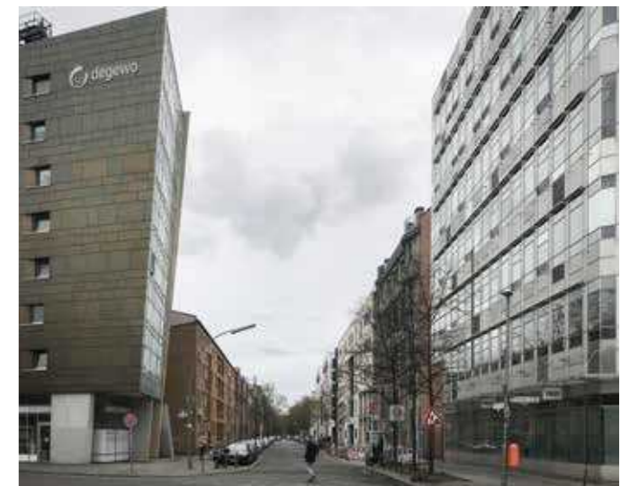
43: Eingangssituation, Dessauer Straße
