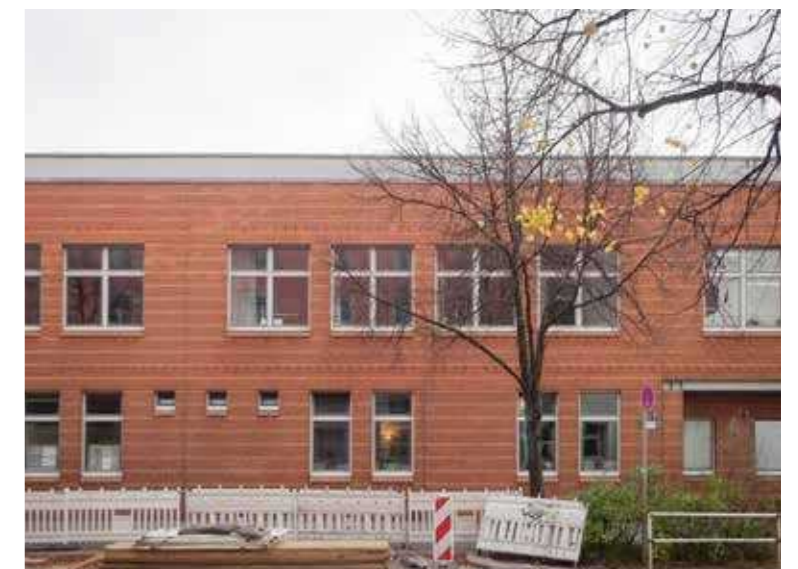
98: Klinkerfassade mit rechteckig, stehenden Zwei bzw. Viersprossenfenster, Schöneberger Straße
