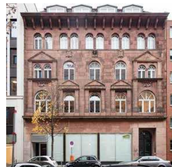
69: Rote Sandsteinfassade, Verzierungen und Fensterformen als Gestaltungselemente, Köthener Str
