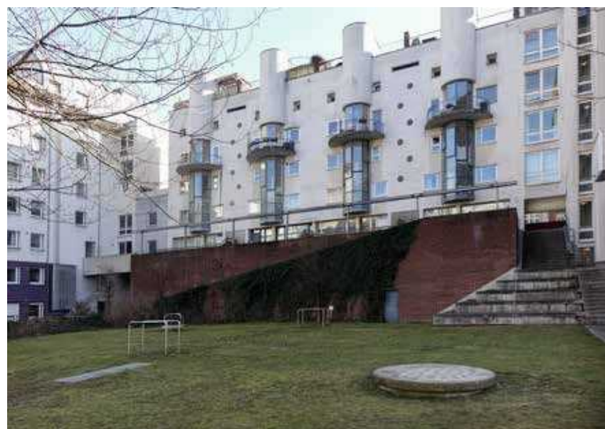
34: Innenhof Gebäudezugängen von Wohnbebauung südlich der Zimmerstraße
