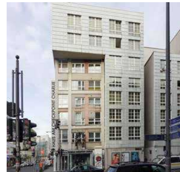
114: Bauliche Anlage, die den Straßenraum um den Checkpoint Charlie optisch dominiert und Strahlkraft besitzt, Friedrichstraße/ Rudi-Dutschke-Straße
