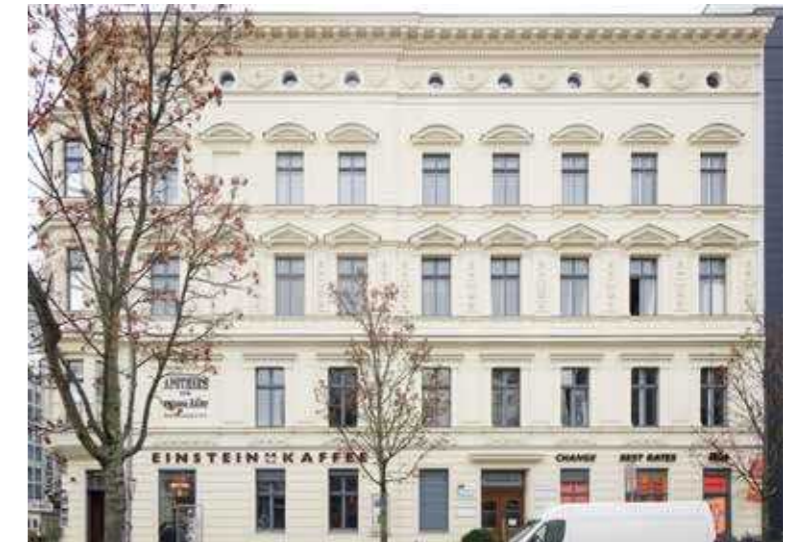
113: Beispiel für eine gründerzeitliche Bebauung, die durch seinen visuellen Anspruch und seine Positionierung als Eckgebäude den Straßenraum prägt und als Eingangstor ins Gebiet fungiert, Zimmer-/ Ecke Friedrichstraße
