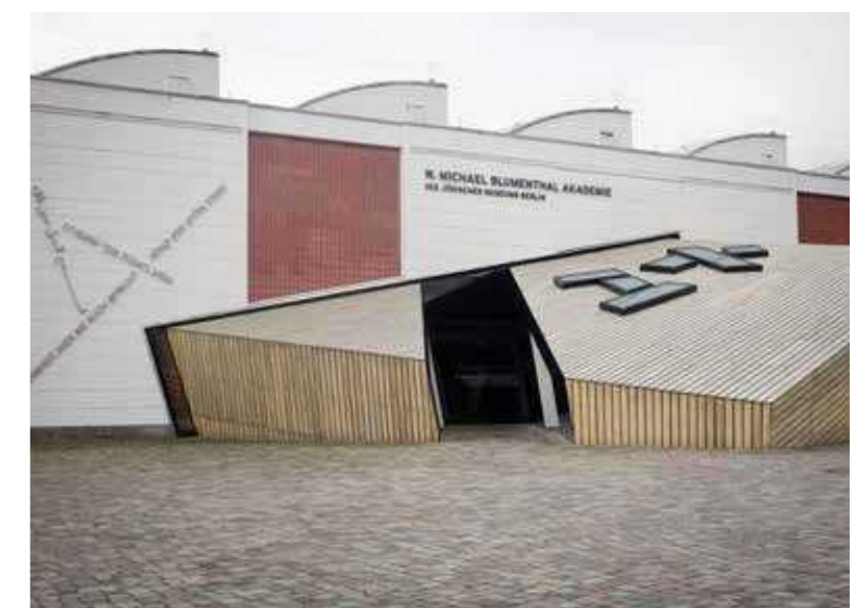
88: Ehemaliger Blumengroßmarkt; heute mit Anbau und kultureller Nutzung, Lindenstraße
