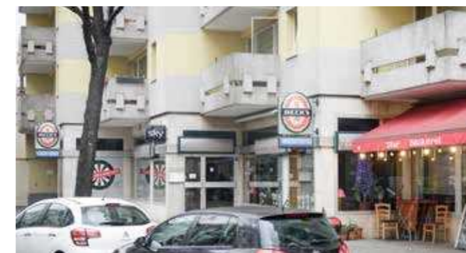
138: Ausladend und durch Wiederholung überzogen wirkende Gestaltung des Erdgeschosses durch Werbeanlagen verschiedener Größe und Form, Stresemannstraße
