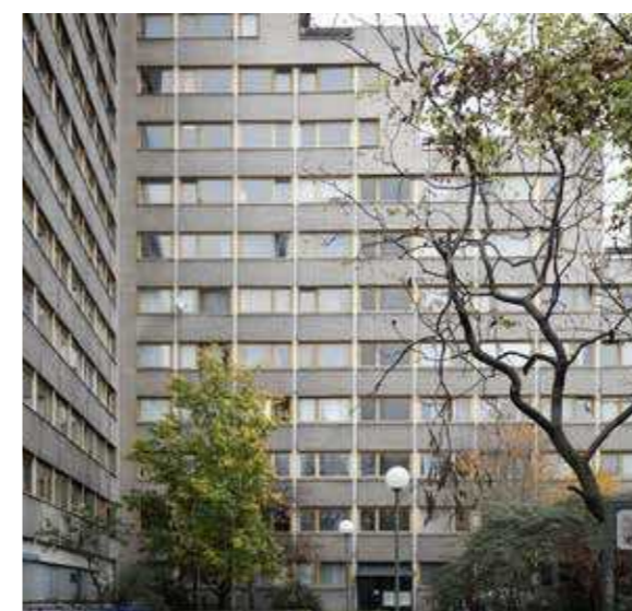
81: Waschbeton mit Kieselbesatz & gelbe Akzentuierung der Fenster, Am Hafenplatz
