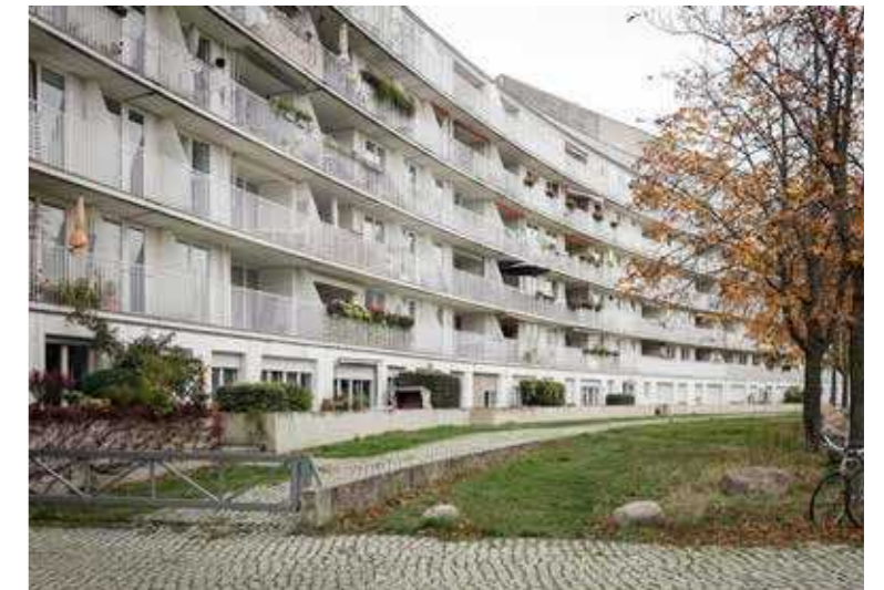
121: Bauliche Anlage, die den Fanny-Hensel-Weg baulich fasst und ebenfalls ortsbildtypische Merkmale aufweist, Fanny-Hensel-Weg
