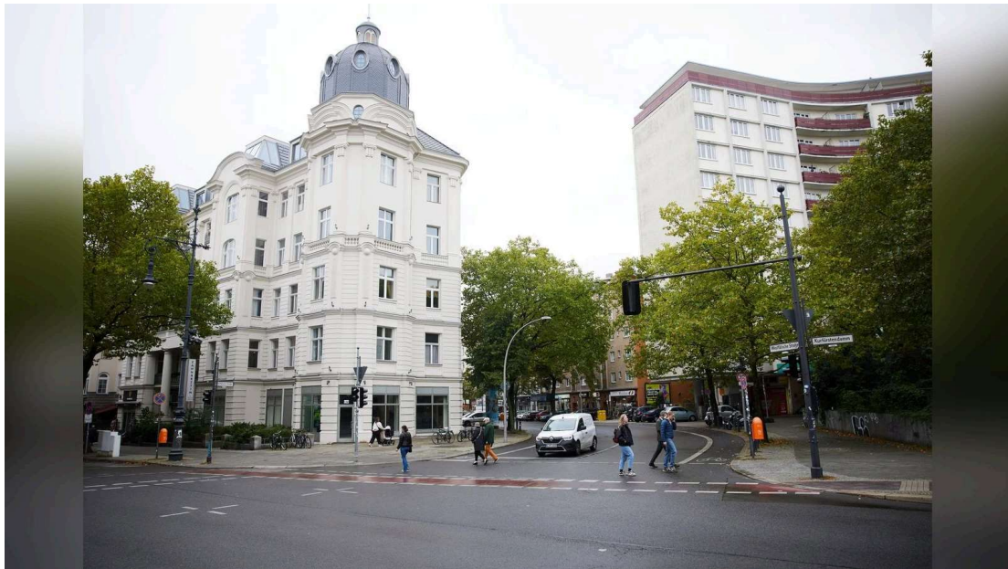
So sieht die Kreuzung Westfälische Straße/Kurfürstendamm am Henriettenplatz heute aus. © FUNKE Foto Services | Jörg Carstensen
