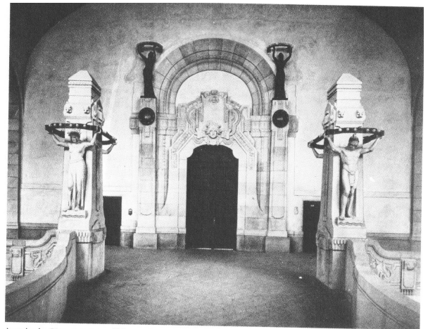
Austritt der Haupttreppe und Turmsaalportal, 1905. Bildhauer: Heinrich Giesecke und Otto Stichling
