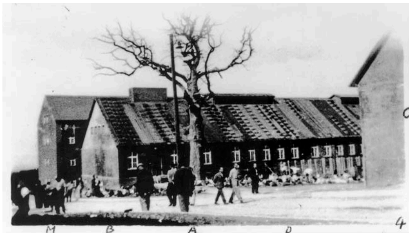
[Signatur: 007-01.001] Häftlinge laufen auf der Lagerstraße. Blick auf die Goethe-Eiche. Im Hintergrund die Wäscherei, dahinter das Kammergebäude. Ganz rechts im Vordergrund das Gebäude der Häftlingsküche. Juni 1944. Fotograf: Georges Angéli © Gedenkstätte Buchenwald
