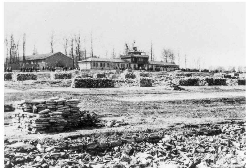
[Signatur: 277.031] Blick auf das Torgebäude aus nordöstlicher Richtung. Zum Zeitpunkt der Aufnahme am 11. April 1952 lag noch Baumaterial vom Abbruch der Holzbaracken auf dem Gelände – eine Maßnahme auf Beschluss des SED-Politbüros. © Gedenkstätte Buchenwald
