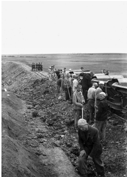
[Signatur: 003-01.201] Häftlinge beim Bau der Bahnstrecke Weimar-Buchenwald, im Hintergrund eine Gruppe SS-Offiziere. Für die Strecke waren ursprünglich drei Monate Bauzeit vorgesehen — um diesen Zeitplan zu erzwingen, trieb man die Häftlinge rücksichtslos an. Frühjahr 1943 © LATH – HStA Weimar
