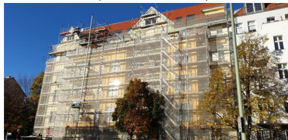
Abbildung 25: Aktuelle Bautätigkeit (Detmolder Straße)
