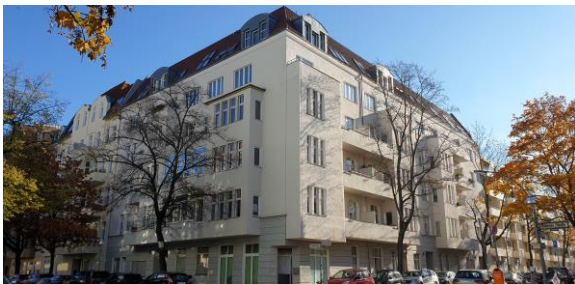
Abbildung 22: Ausgebautes Dachgeschoss (Aachener Str./Paretzer Str.)
