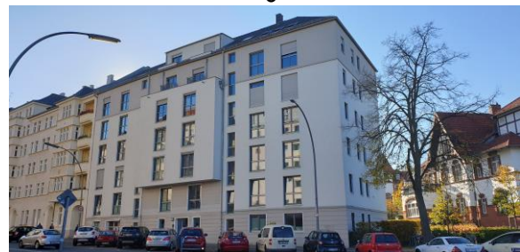
Abbildung 17: Sanierte Fassade mit Fassadendämmung
