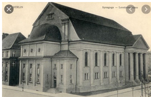
Die Synagoge Levetzowstraße
